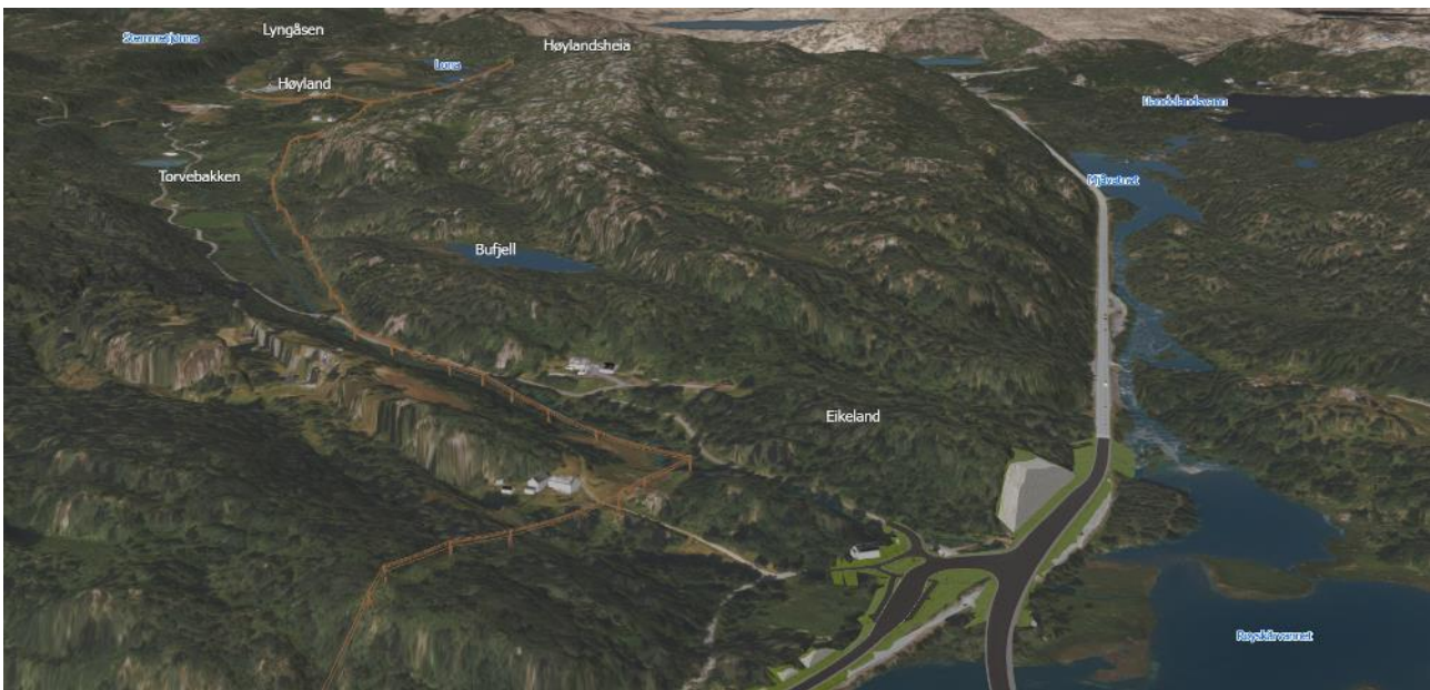
Figur 3-3: Høylandsheia med dagens E39 og Høylandsdalen på hver sin side, samt pågående byggeprosjekt på Røyskår
