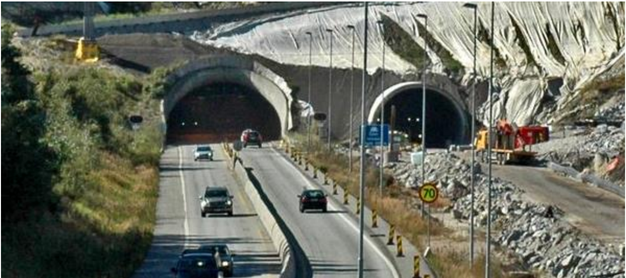
Figur 7-25: Eksempel på tunnelbygging. Nytt løp satt i drift med toveis trafikk mens eksisterende tunnel opprustes
