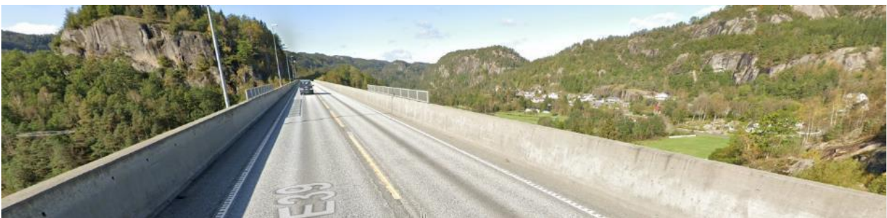
Figur 3-17: Refsti sett fra bru på E39. Kilde: Google Maps
