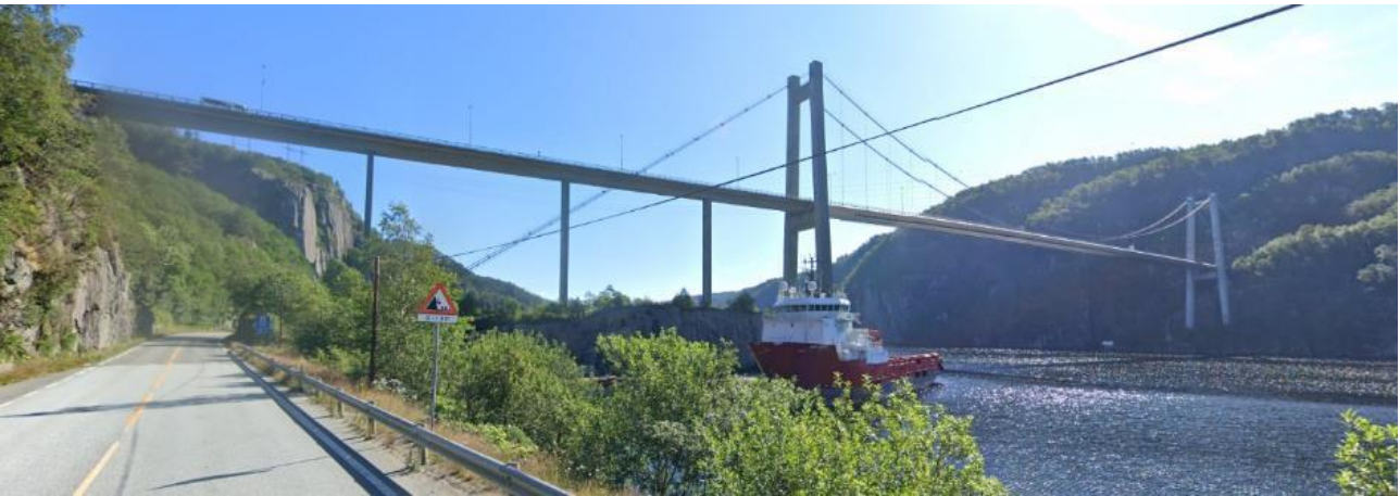
Figur 3-15: Fedafjorden bru sett fra Angholmveien. Kilde: Google Maps
