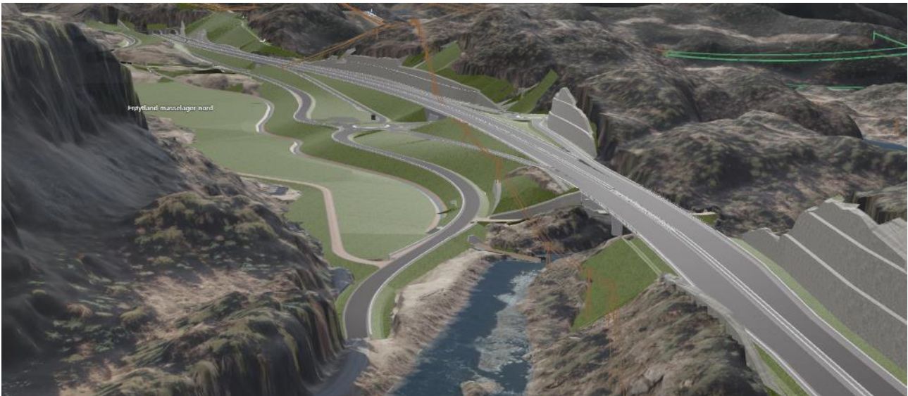
Figur 7-40: Nytt kryss på Frøytland sett fra Lona. Den omlagte Frøytlandsveien mot nord og ny seksfelts bru over Frøytlandsfossen
