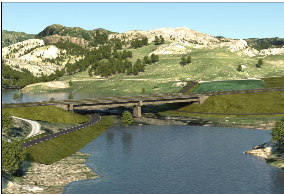
Figur 4-5. Strekning C. Passasje Kjedlandsåna, sett fra vest.
