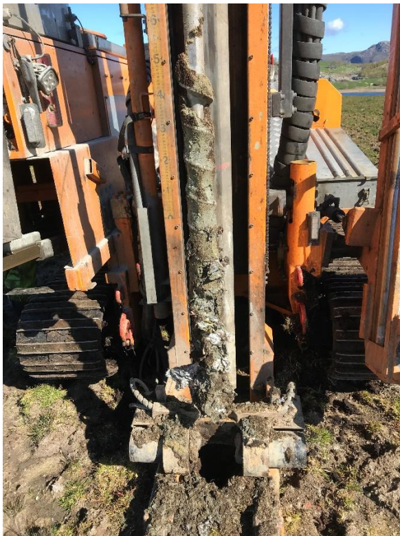
Figur 6: Massene i E49, 1-2 m. Det er mye plast og annet avfall i massene fra 1,5-2 m.
