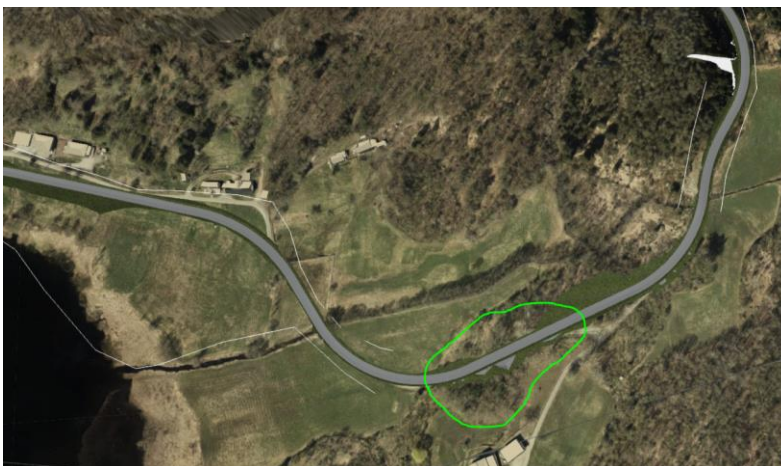
Figur 23: Vatland/Hårikstad hagemark på begge sider av Vintlandsveien. Området er vist som midlertidig rigg- og anleggsområde.
