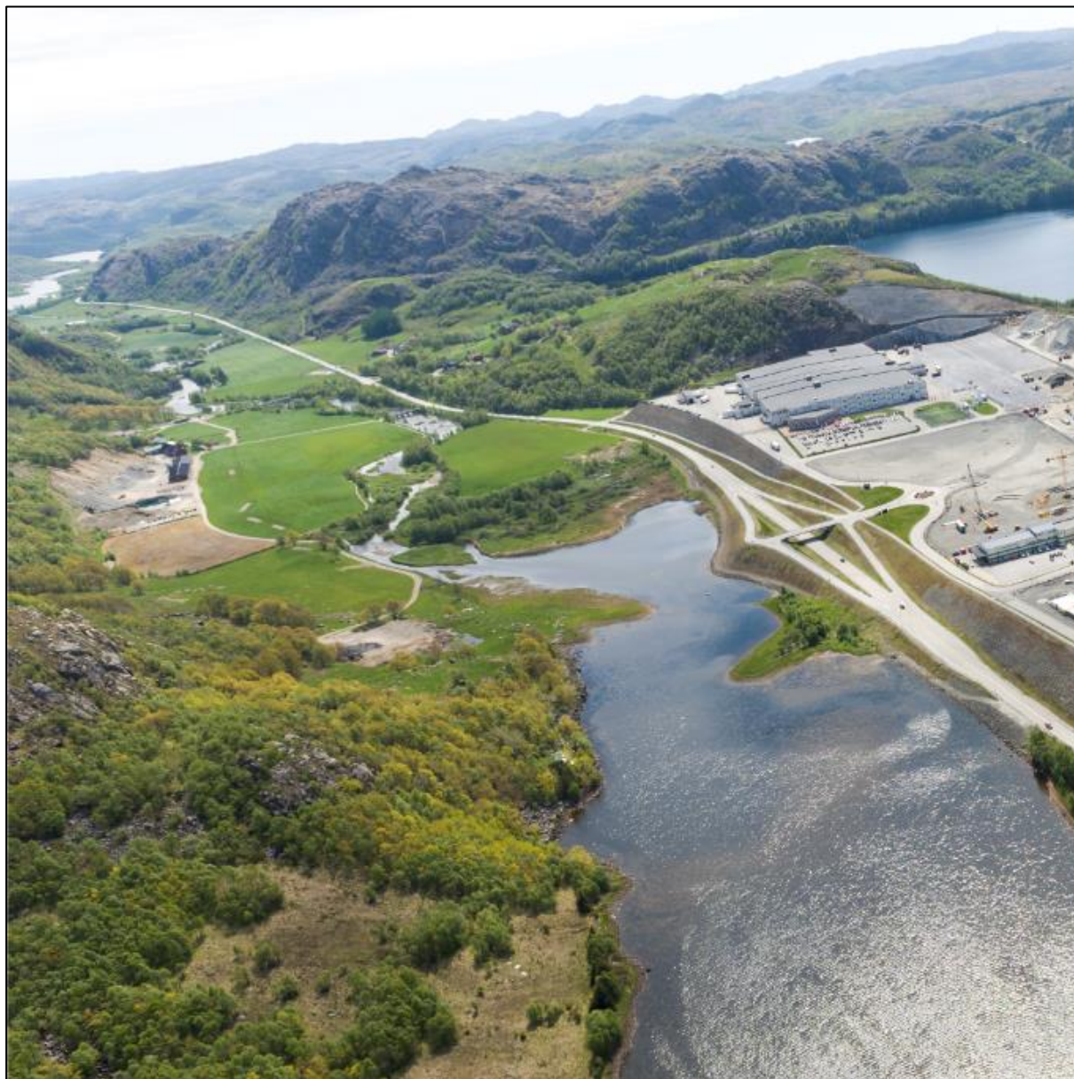
Figur 6-60: Delområdene J10 Haraland og J11 Skurvemarka sett fra helikopter. Foto er tatt i sørlig retning (Kilde; Statens vegvesen).
