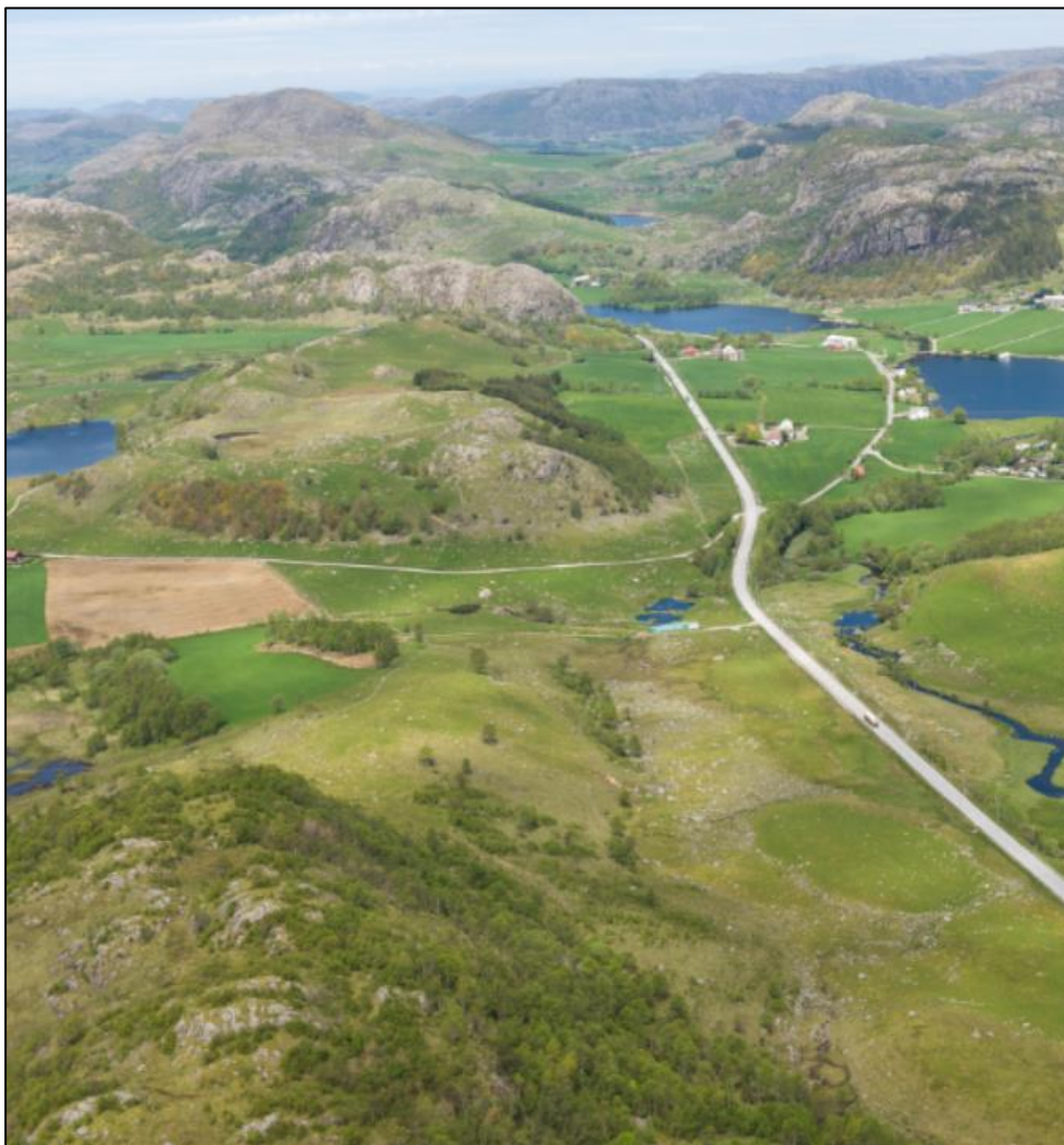
Figur 6-46: Delområdet J8 Store Pighammaren ligger vest for eksisterende E39. Foto er tatt mot nord (Kilde; Statens vegvesen).
