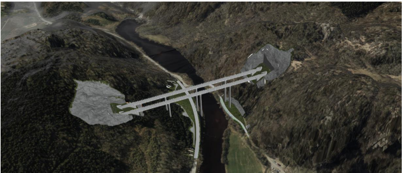
Figur 8: Kvelland bru sett fra nordøst. Her viser modellen ferdig fase. Tunnelpåhuggene utgjør tydelige landskapsinngrep som forsterkes av omfattende arealer med blottlagt berg.
