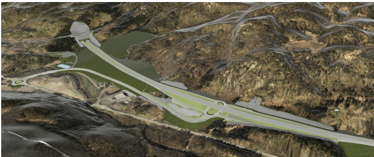
Figur 3: Herdal sett fra sørøst. E39 med ramper forårsaker kraftige, langsgående bergskjæringer.
