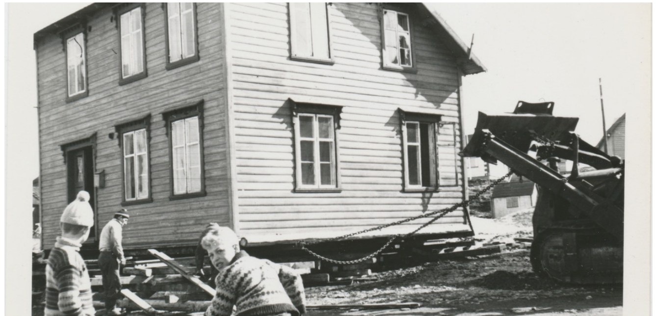
Figur 3. Et bolighus i Vardø flyttes på 1960-tallet; tomten skulle benyttes til ny yrkesskole i byen, og tømmerhuset ble flyttet til en ledig tomt i nærheten. Foto: Trygve Karlsen/Vardø museum.
