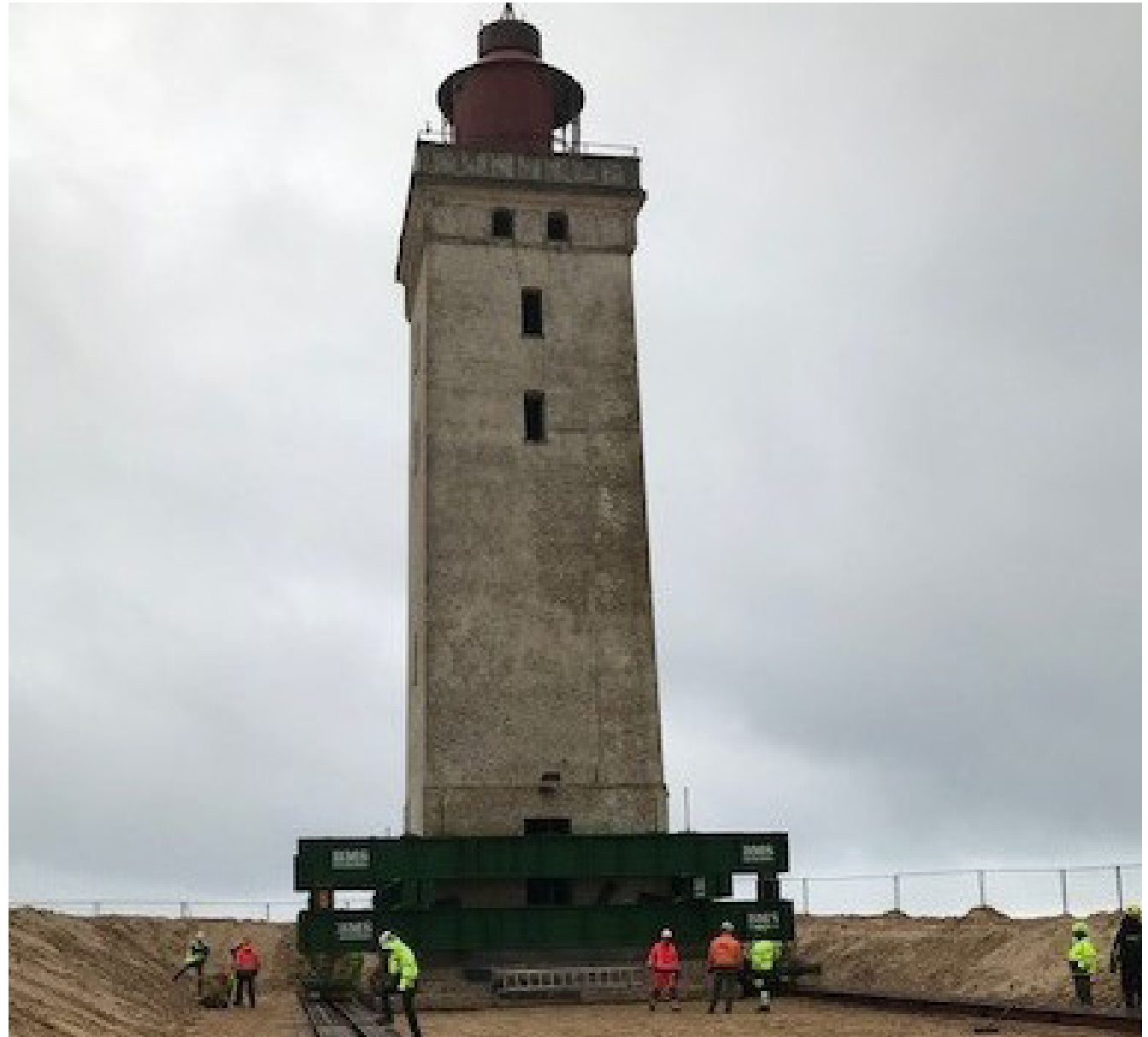
Figur 22. Rubjerg fyr flyttes på skinner i oktober 2019. Foto: fyretflytter.dk.
