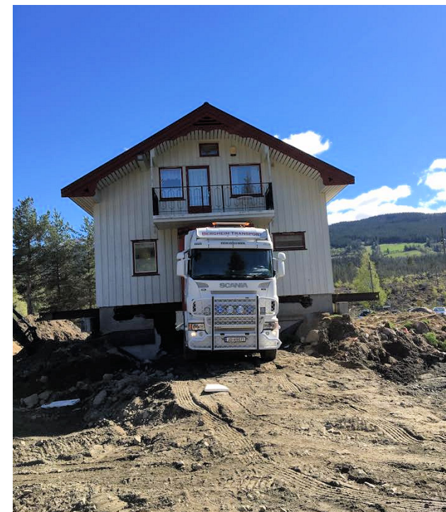
Figur 24. Flytting av hus på 30 tonn. Foto: Bergheim transport.
