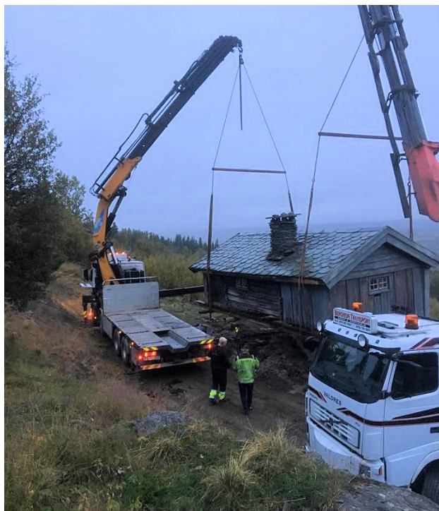
Figur 23. Flytting av hytte med peis og pipe intakt. Foto: Bergheim transport.
