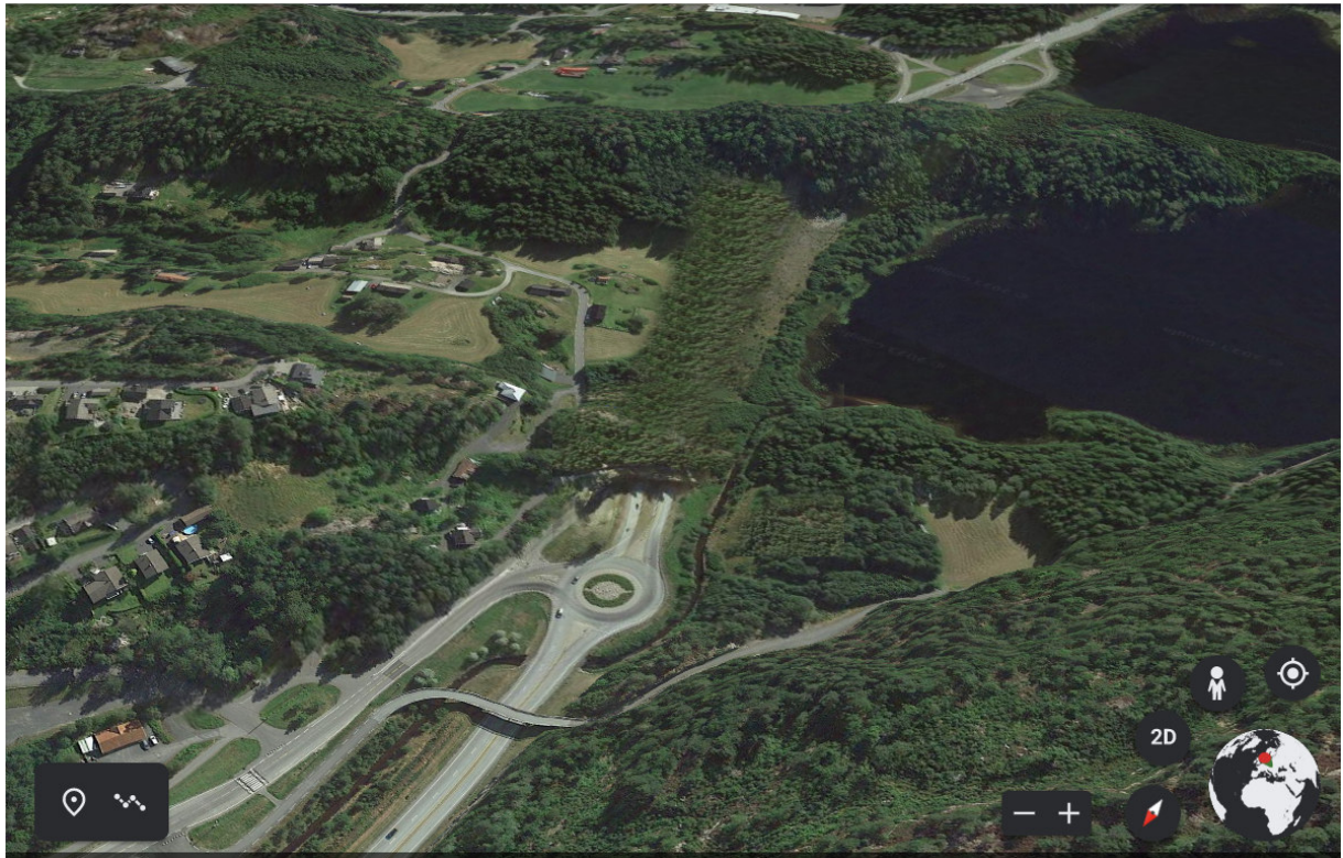
Kulvert fra Kvienga til Sørlandsporten
