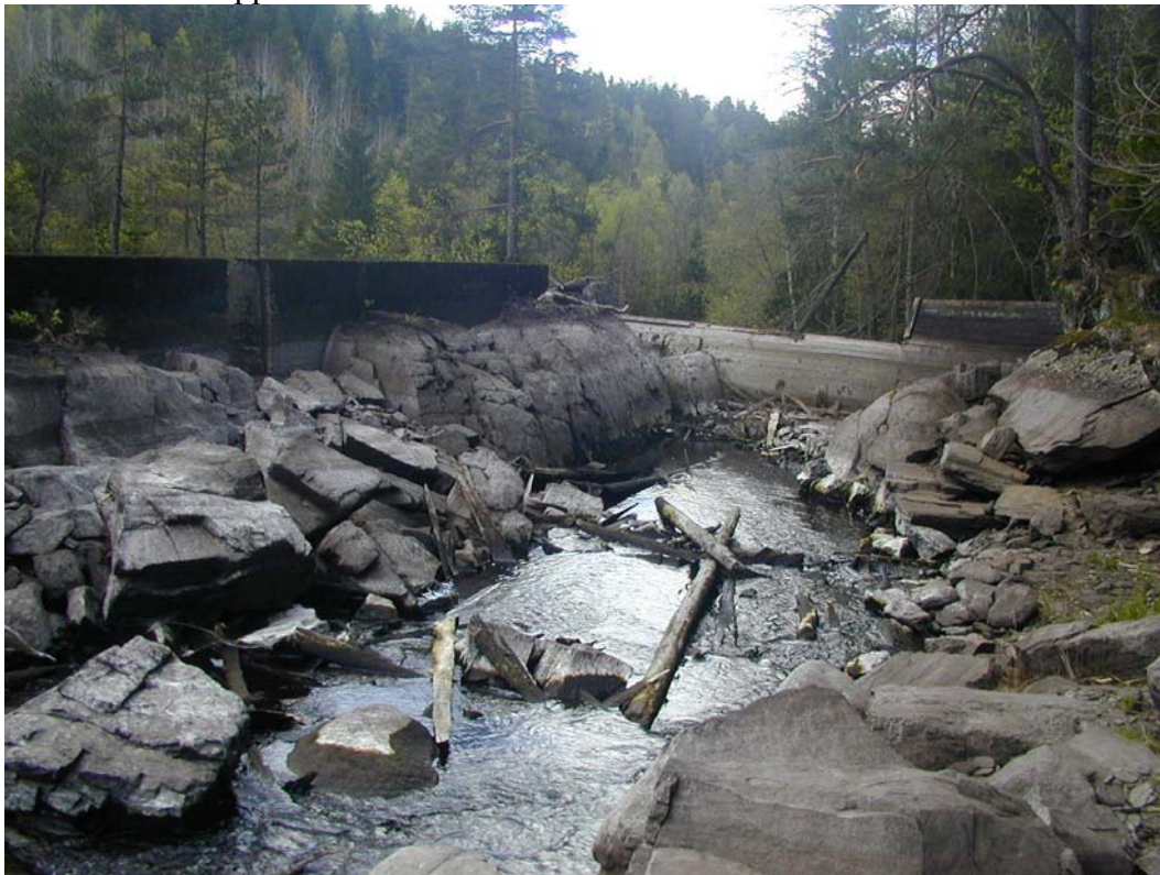
Dammen sett ”oppstrøms” fra.
