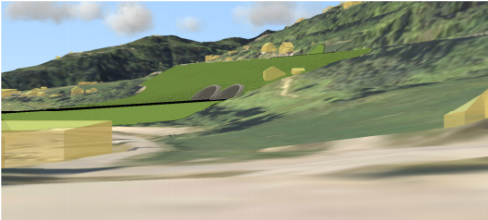
Figur 6-6 Nærvirkning av tunnelportalområdet sett fra Storhove. Høyden på fyllingen ved tunnelportalene er ca. 30 m.
