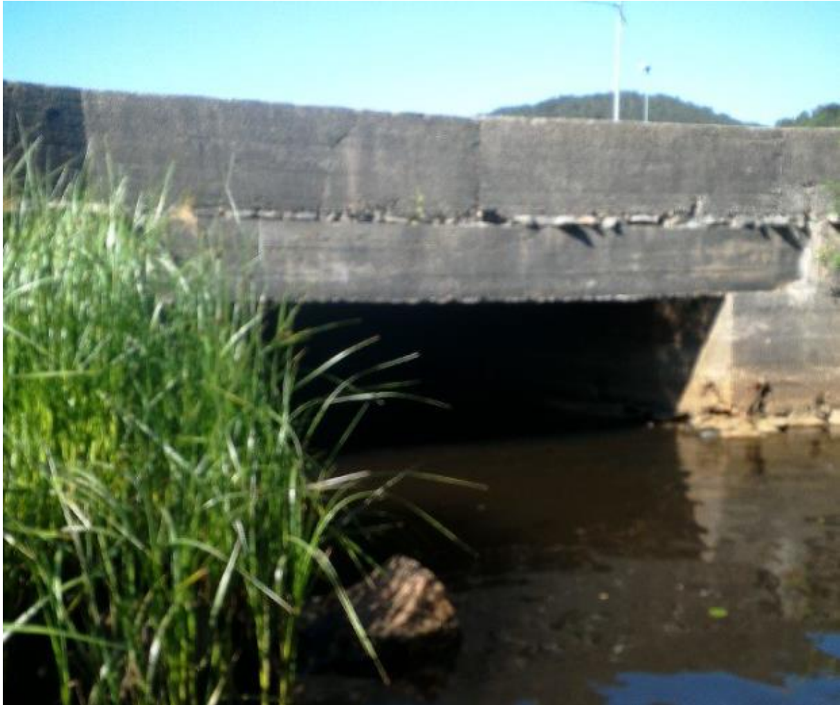
Figur 8-1: Innløp av eksisterende kulvert/bru under fv. 465 Øyesletta.
