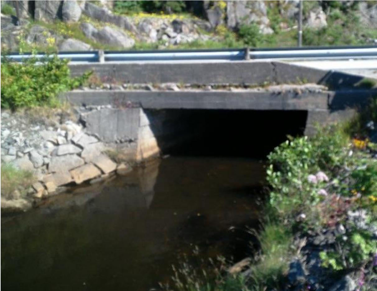
Figur 8-2: Utløp av eksisterende kulvert/bru under fv. 465 Øyesletta.
