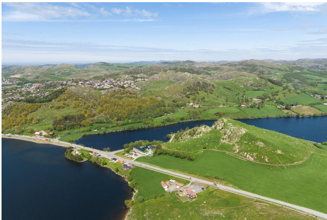
Figur 6-18: Dagens E39 på fylling mellom Edlandsvatnet og Limavatnet. Kilde Statens vegvesen
