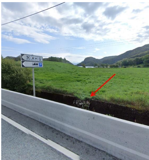
Figur 4-16: Utløpspunkt til kanal
