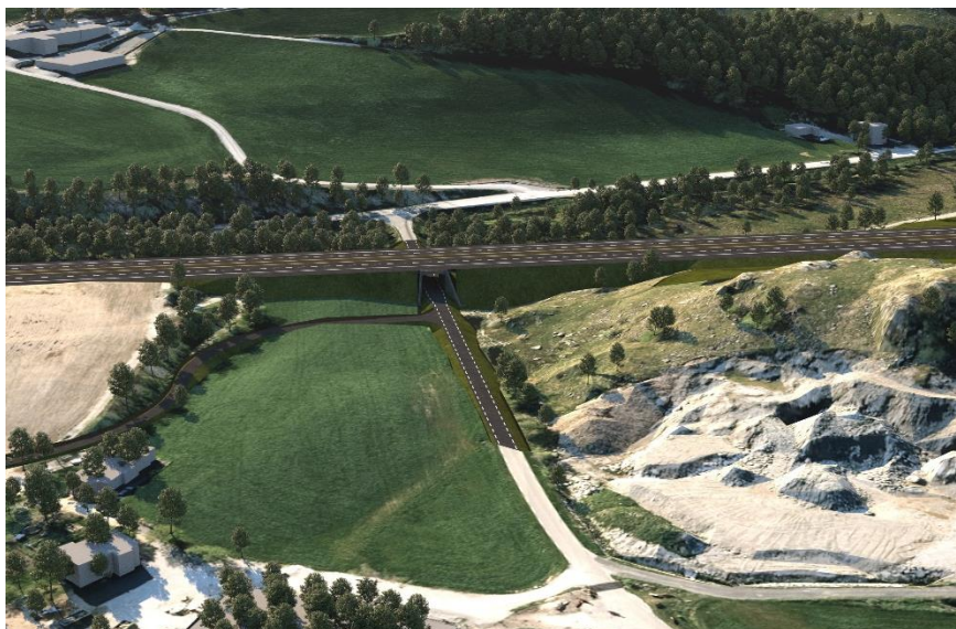
Figur 6-9: K301 kulvert Nedrebøvegen
