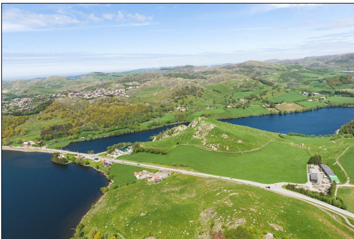
Figur 6-23. Eksisterende E39 ved Bollestad sett fra sør. Edlandsvatnet ses til venstre, og Limavatnet til høyre i bildet. Foto: Statens vegvesen
