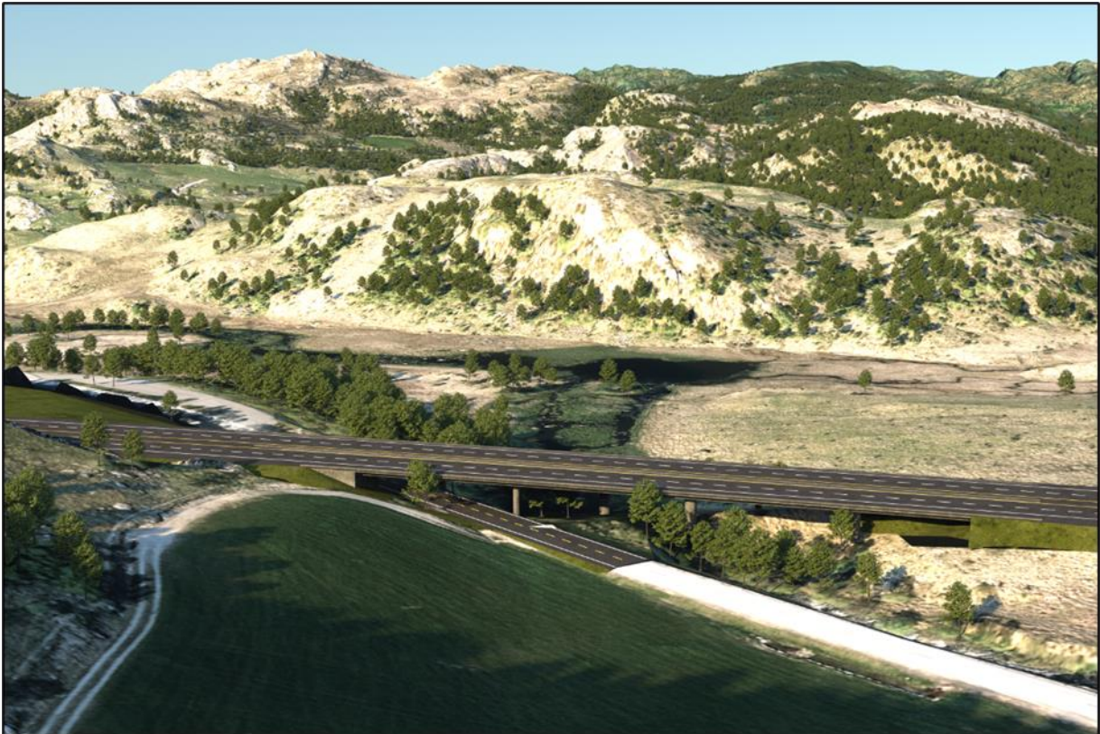
Figur 6-12. Flerbruksløsning under bru, sett fra sør-vest.
