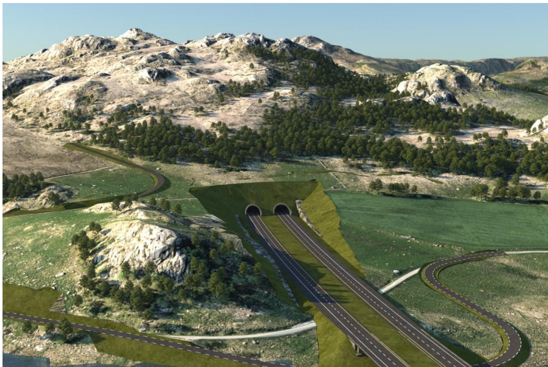
Figur 6-17. Søndre portal til tunnel gjennom Tindafjellet.
