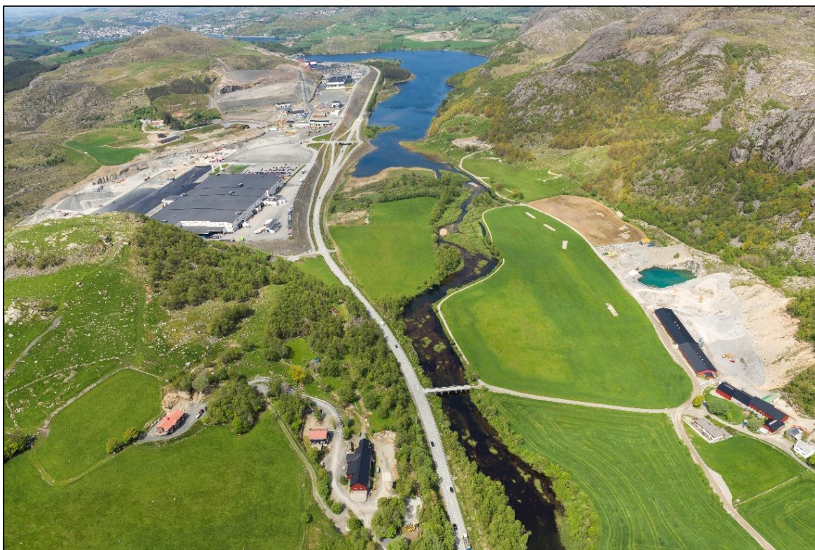
Figur 6-20. Eksisterende E39 ved Auestadåna sett fra sør. Klugsvatnet ses i øvre del av bilde. Foto: Statens vegvesen.
