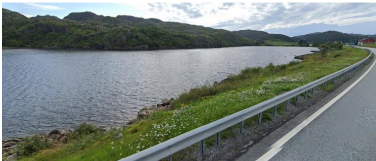
Figur 4-5: Kantsone til Ytra Kydlandsvatnet ved dagens E39 med varierende bredde fra veien (kilde: maps.google)
