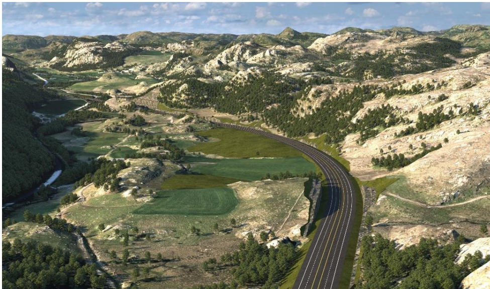
Figur 4-2: Utklipp fra visningsmodell viser avgrensede områder for permanent masselagring i Gautedal og tilpasning til eksisterende landskap og terrengformer.
