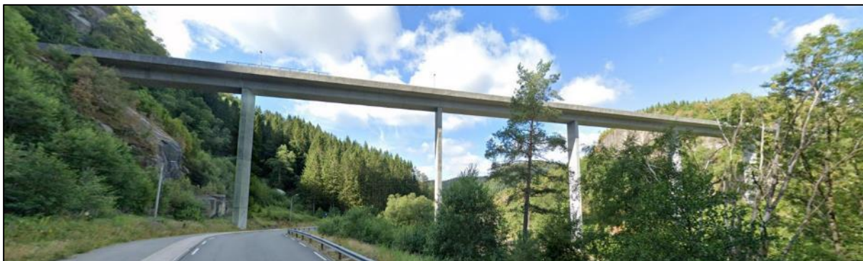
Figur 2-4 E39-bru sett fra Høylandsveien. Kilde: (Google Maps)
