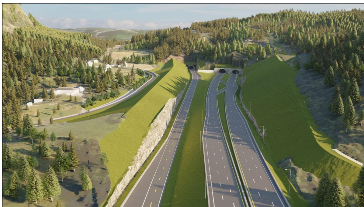
Figur 3-13 Massevoll som demper støy mot bebyggelsen.
