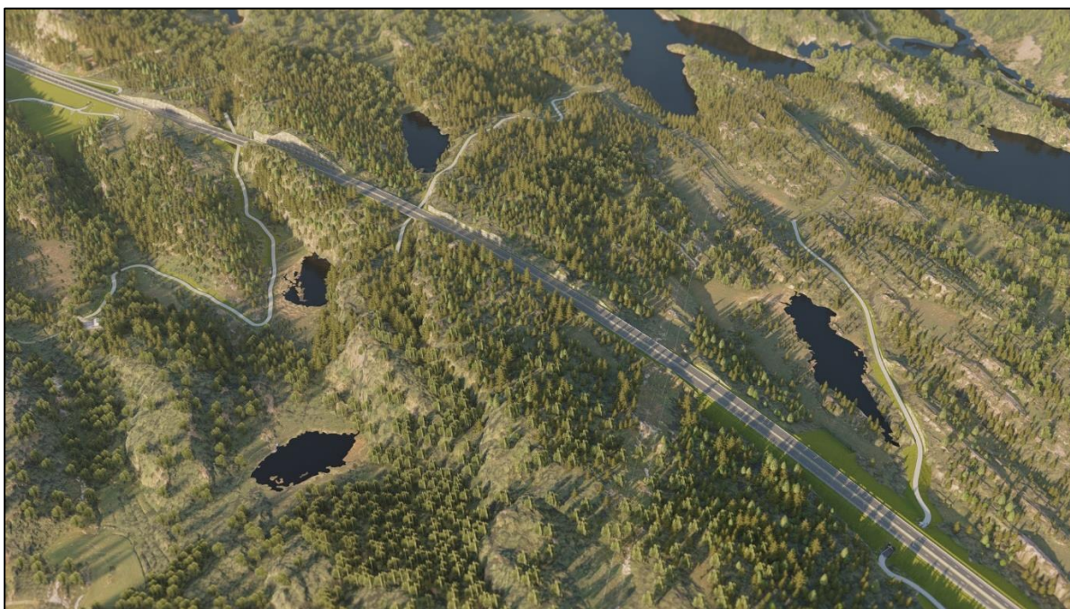
Figur 3-18 Anleggsveier som vil bli driftsveier for landbruk etter endt anleggsperiode.
