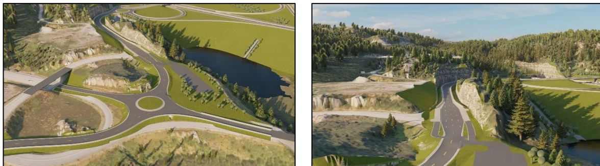
Figur 3-8 Venstre: Ny rundkjøring ved dagen E39. Høyre: Busslommer langs veien mellom rundkjøringene.
