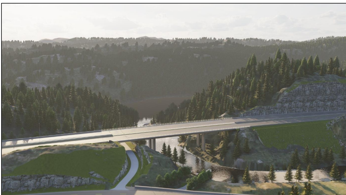
Figur 3-24 K260 Frøitlandsfossen sett fra øst.
