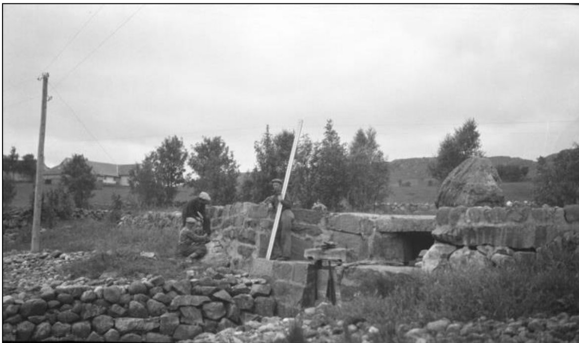
Figur 5-6 Reguleringsdam ved Ytra Kydlandsvatnet. Fotografiet er datert til 1934. Kilde: Digitaltmuseum.no.
