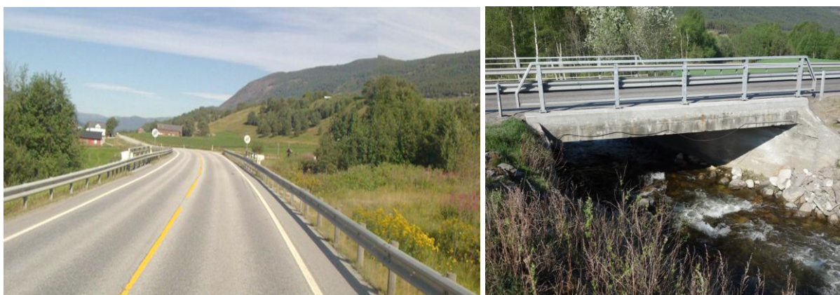
Figur 5-9: Venstre: Oversiktsbilde av brusted, sett fra sør mot nord. Høyre: Oversiktsbilde av bru, sett mot vest (fra oppstrøms side). (Kilde: Sweco)
