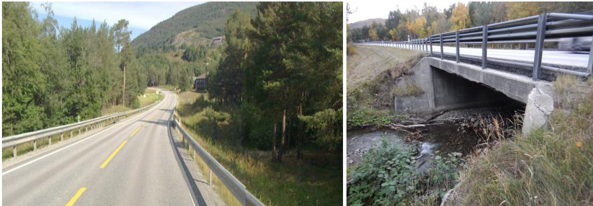
Figur 5-10: Venstre: Oversiktsbilde av brusted, sett fra sør mot nord. Høyre: Oversiktsbilde av bru, sett mot sør (fra oppstrøms side). (Kilde: Sweco)
