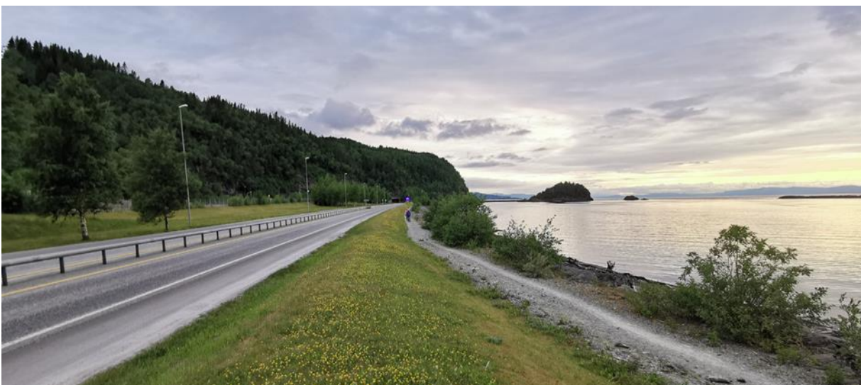
Figur 6-3: E6 langs Hellstranda og Trondheimsfjorden (Foto: Rambøll, 2020).
