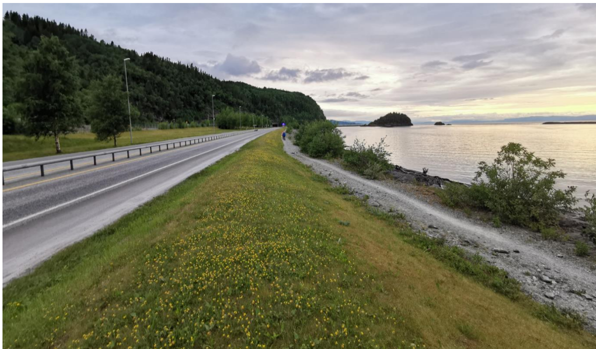
Figur 8-12 Bilde av voll mellom E6 og turveg, foto Rambøll AS
