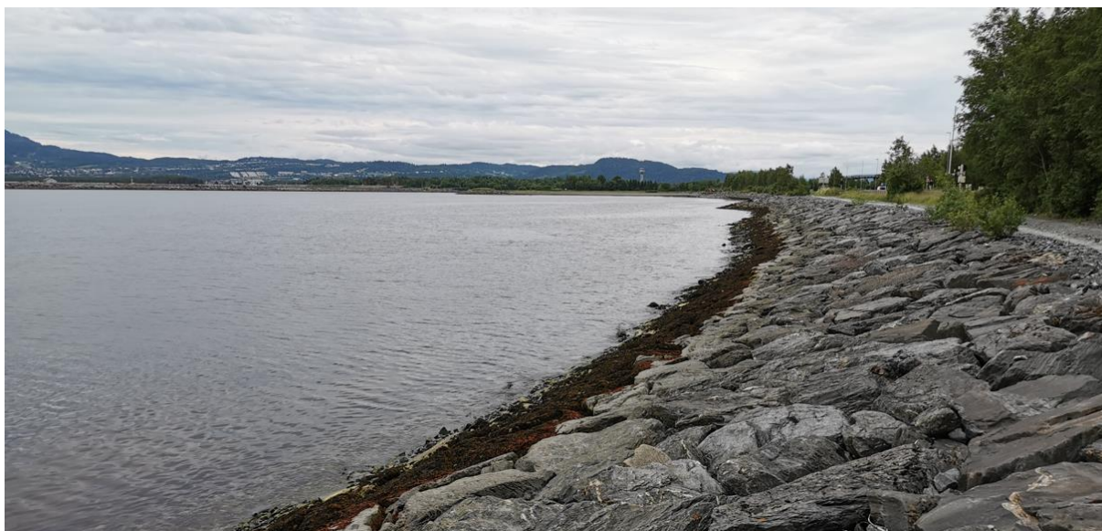
Figur 8-14 Bilde av plastring og landskapsrommet på Hellstranda, foto Rambøll AS
