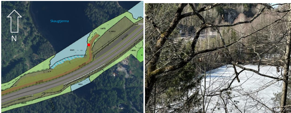
Figur 6-41: Utfyllingen i Skaugtjenna. Foto til høyre tatt fra ca. rødt punkt, viser hvordan dagens utfylling i Skaugtjenna «kutter» over innsjøen (Sweco Norge)
