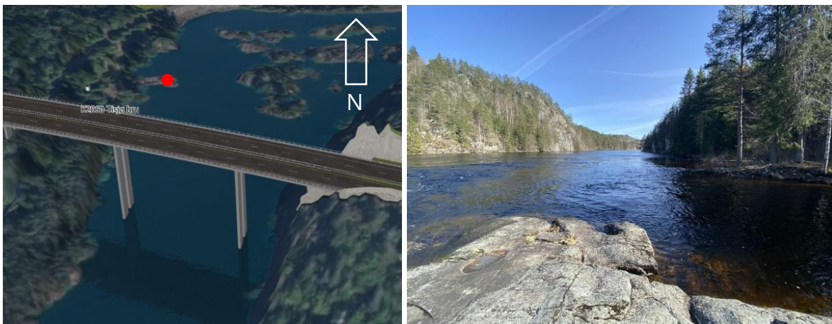
Figur 6-30: Tisjø bru sett fra sør. Foto viser Tisjø sett fra vestre bredd (rødt punkt) og sørover mot punkt for brukryssing (Sweco Norge)
