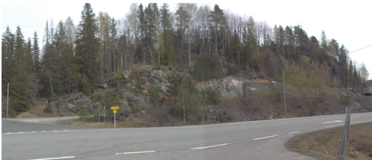
Figur 8-3: Vegbilde fra [8] som viser skråningen der aktsomhetsområdet for snøskred er ved Gjerdemyrakrysset. Sett mot øst.
