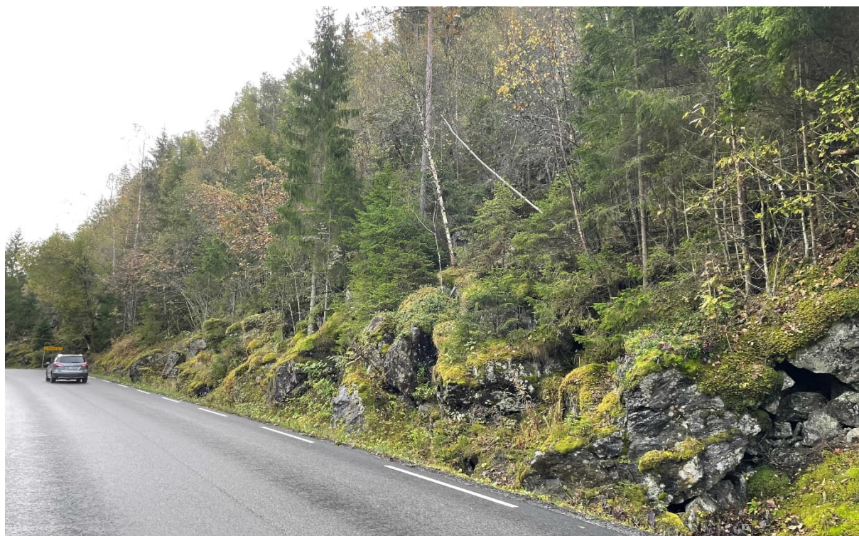
Figur 14-5: Urmasser langs Gamle Sørlandske (sidevei 23200) mellom krysset til gamle Rørholtveien og der ny kulvert under E18 skal bygges. Sett mot øst. Fotograf Ingvild Sangesland Qvist.
