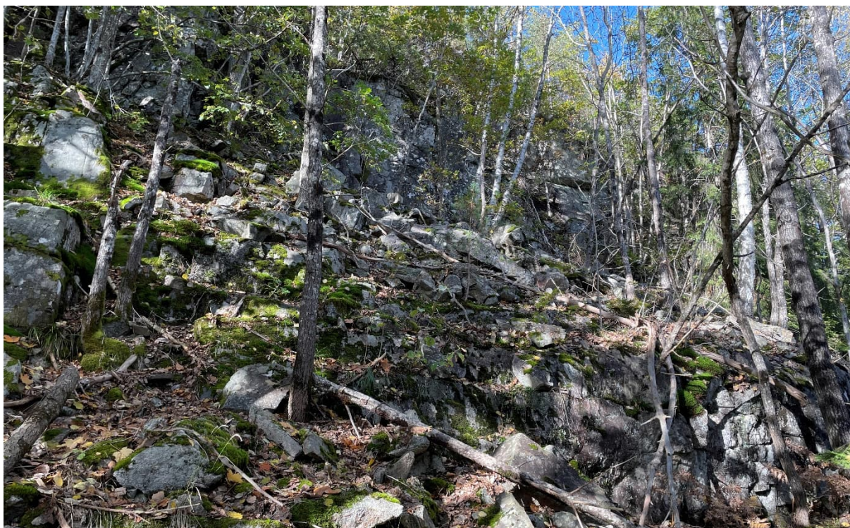
Figur 9-8: Urmasser i underkant av bergskrent til venstre for hovedvei ved ca. profil 10050. Sett mot nord. Fotograf Ingvild Sangesland Qvist.
