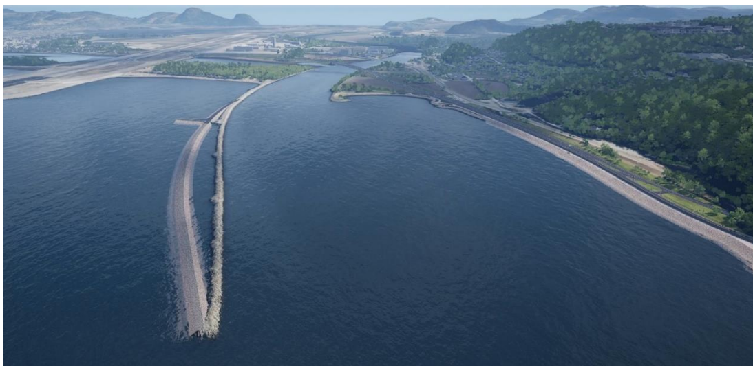
Figur 8: Illustrasjon av gjenstående kompensasjonstiltak som innebærer en justering av eksisterende molo nord for Hellstranda. Merk at dette kun er en illustrasjon, nøyaktig utforming molo vil bestemmes på et senere tidspunkt (Illustrasjon av Rambøll).
