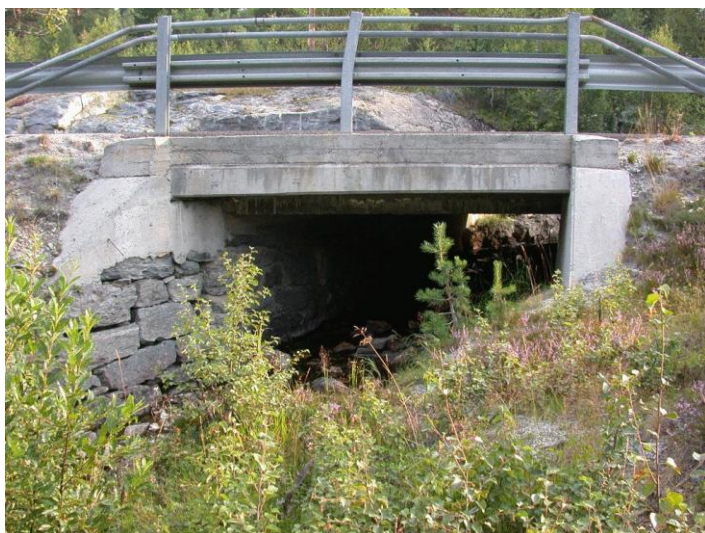
Figur 5-5: Oversiktsbilde av Bakkebekk bru, sett mot nord-øst (fra nedstrøms side). (Kilde: Sweco)
