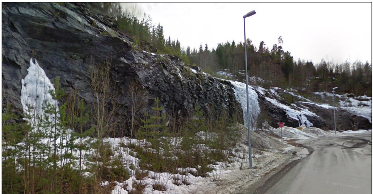
Figur 15 Akkumulasjon av is i eksisterende skjæring. Google streetview, april 2010.
