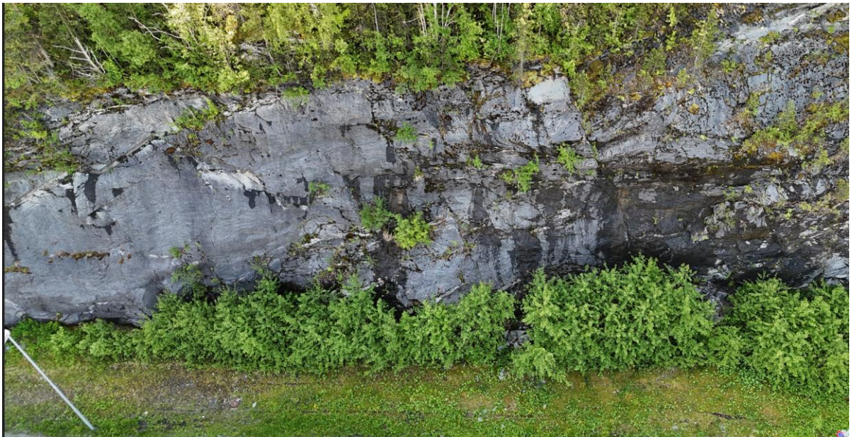
Figur 12. Sprekkeflate med fall/fallretning 60/330.
