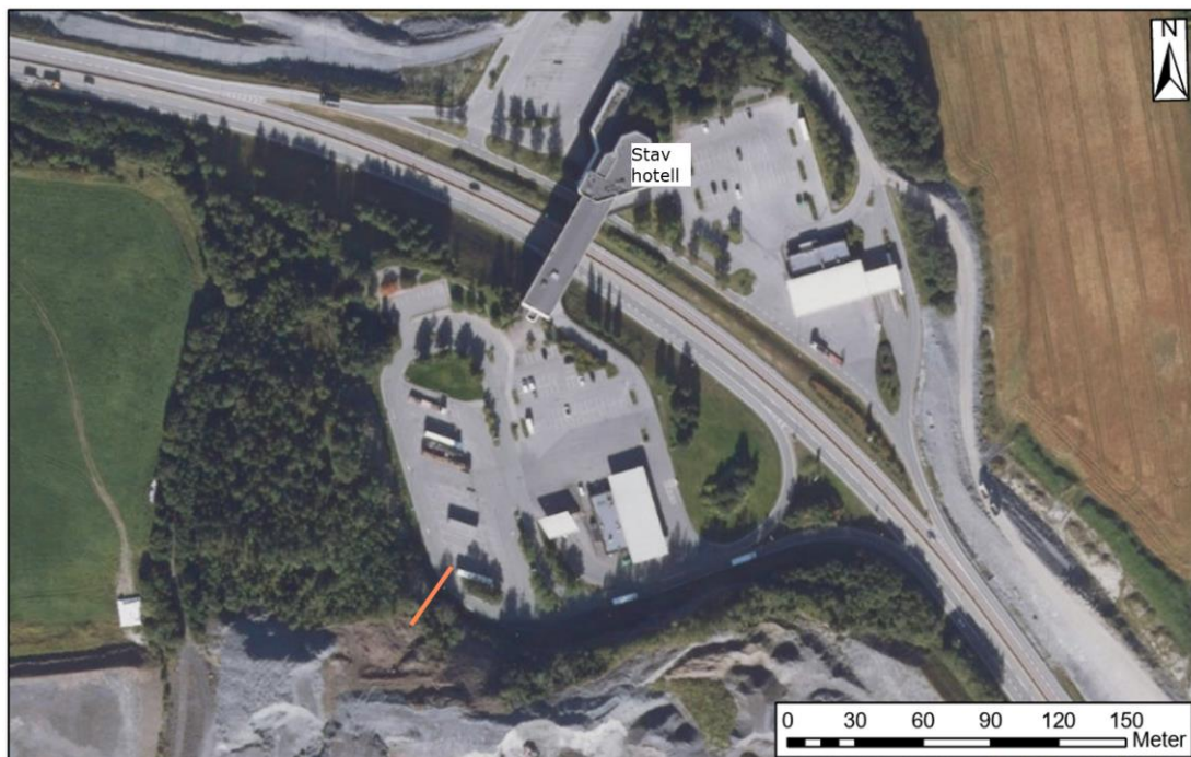
Figur 6. Flyfoto av bergskjæringene som er vurdert. Oransje strek markerer et skille i bergmassens egenskaper og karakteristikk.
