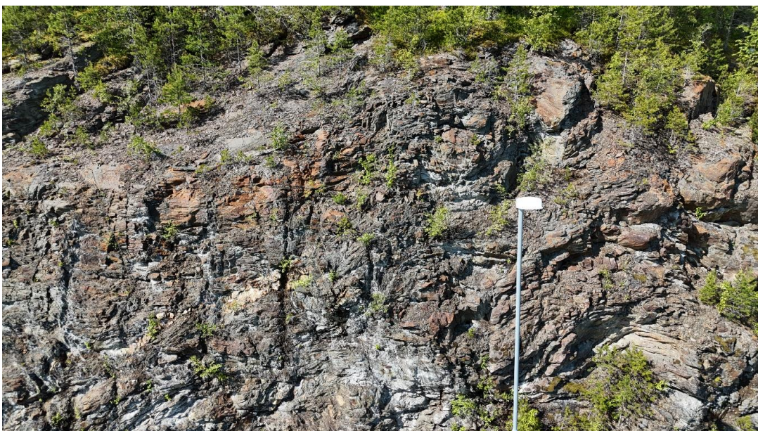
Figur 8. Eksisterende bergskjæring ved fremtidig avkjøringsrampe.
