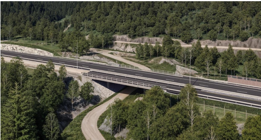
Figur 3-1: Viser høringsforslagets planlagte løsning for faunapassasjen ved Nygård. (Kilde: Sweco)
