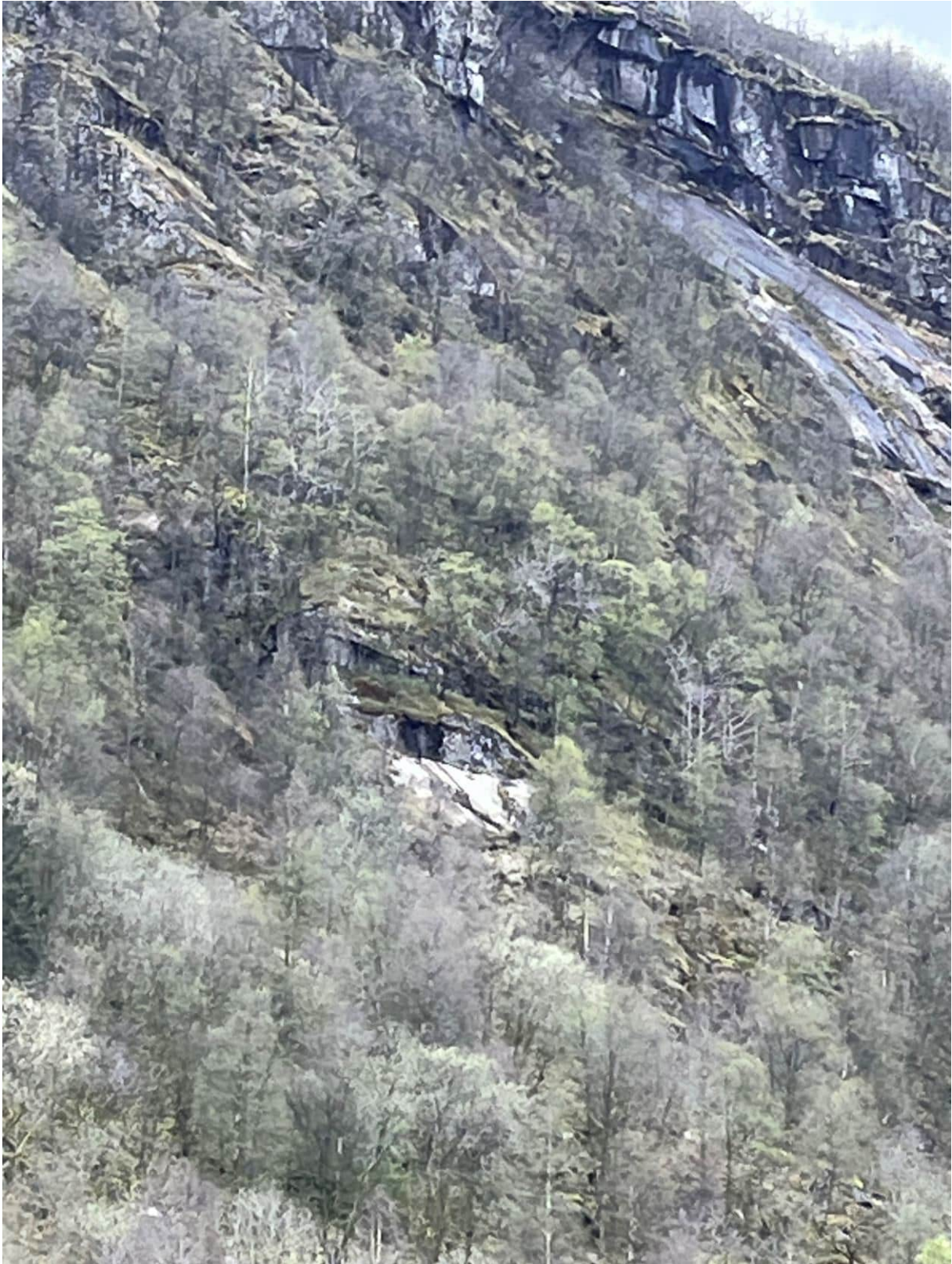
Vedlegg: Rasfarlig fjell 2
