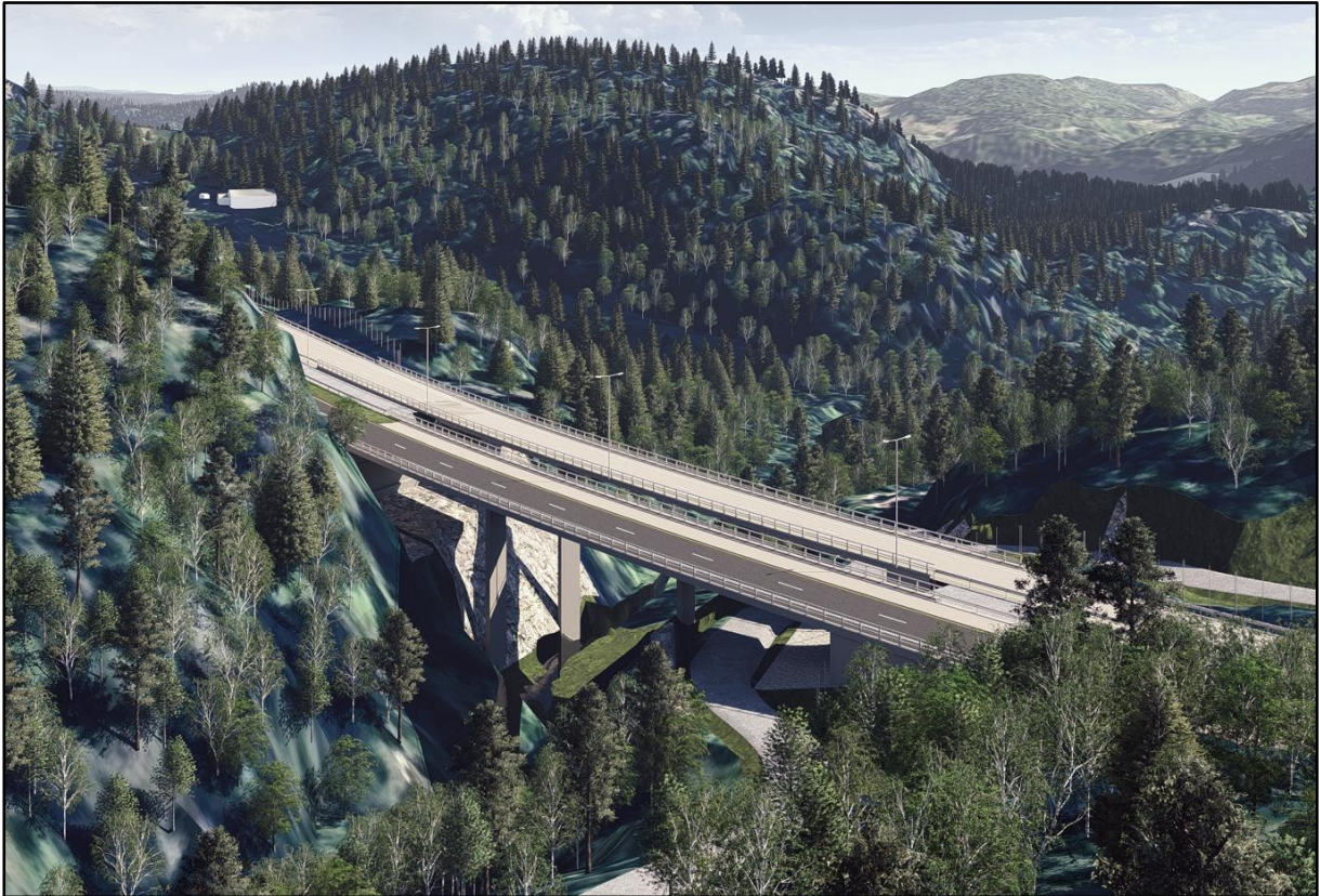
Figur 3-23: Illustrasjon av planlagt bru over Tyvannselva, sett fra nordøst. Dagens bru (lengst vekk i bildet) kan bli erstattet med ny bru for nordgående løp. Ny bru for sørgående løp nærmest i bildet. (Kilde: Sweco)
