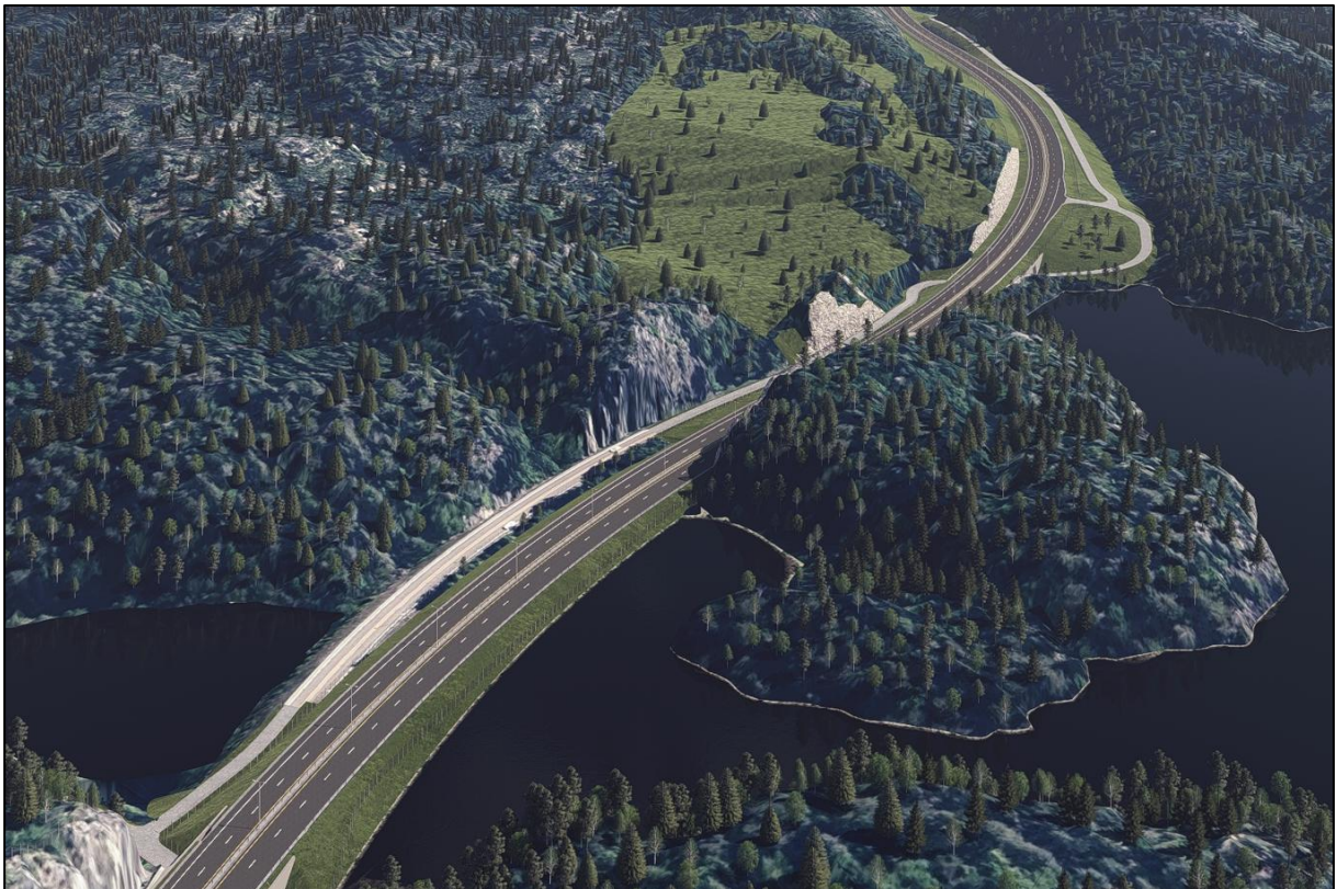
Figur 3-38: Utfylling i Stidalskilen og masselager Vestre Hulldalsstranda, sett fra vest. (Kilde: Sweco)
