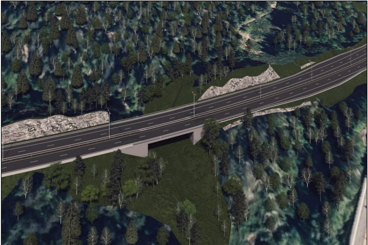
Figur 3-20: Faunapassasjen ved Hegland, sett fra sør. (Kilde: Sweco)
