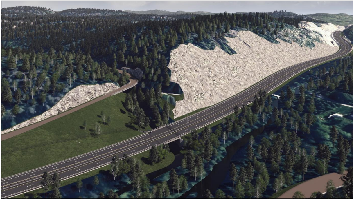
Figur 3-51: Rørholtveien på ny bru og kulvert for omlagt Grasdalstjennbekken, sett fra sør. (Kilde: Sweco)
