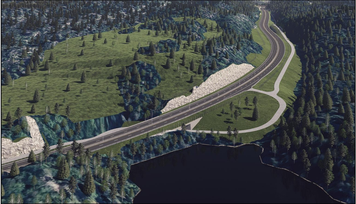
Figur 3-39: Hulldalsstranda kulvert og masselager Vestre Hulldalsstranda noen år etter anlegget er ferdig, sett fra vest. (Kilde: Sweco)
