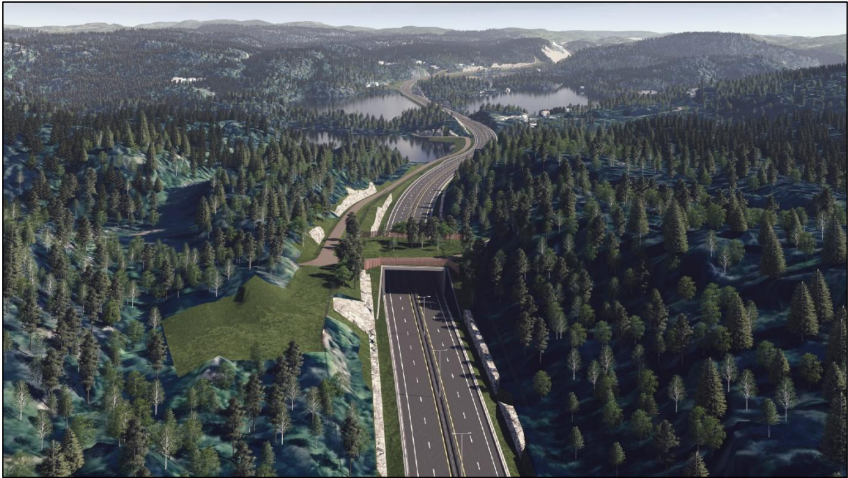
Figur 3-42: Faunapassasje ved Plassen, sett fra vest. (Kilde: Sweco)
