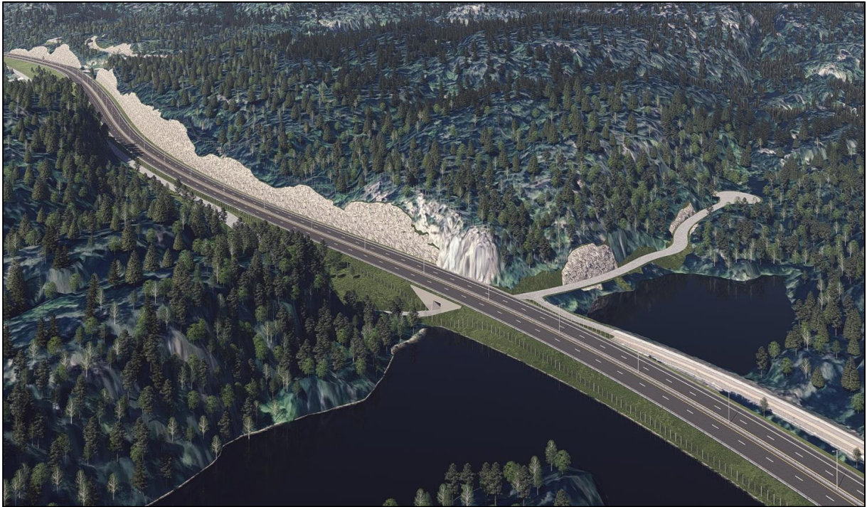
Figur 3-37: Kulvert ved Stidalskilen, sett fra sørøst. (Kilde: Sweco)
