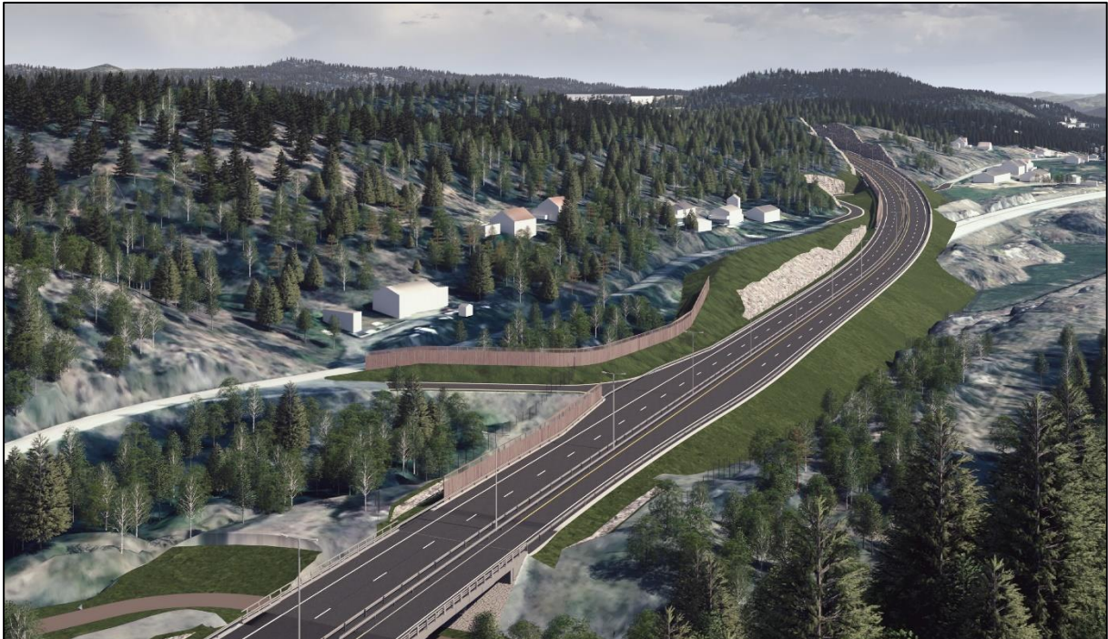
Figur 3-7: Planlagt feltinndeling ved kobling til dagens E18 ved Nygård II bru, to kjørefelt sørover og et nordover. Sett fra øst. (Kilde Sweco)
