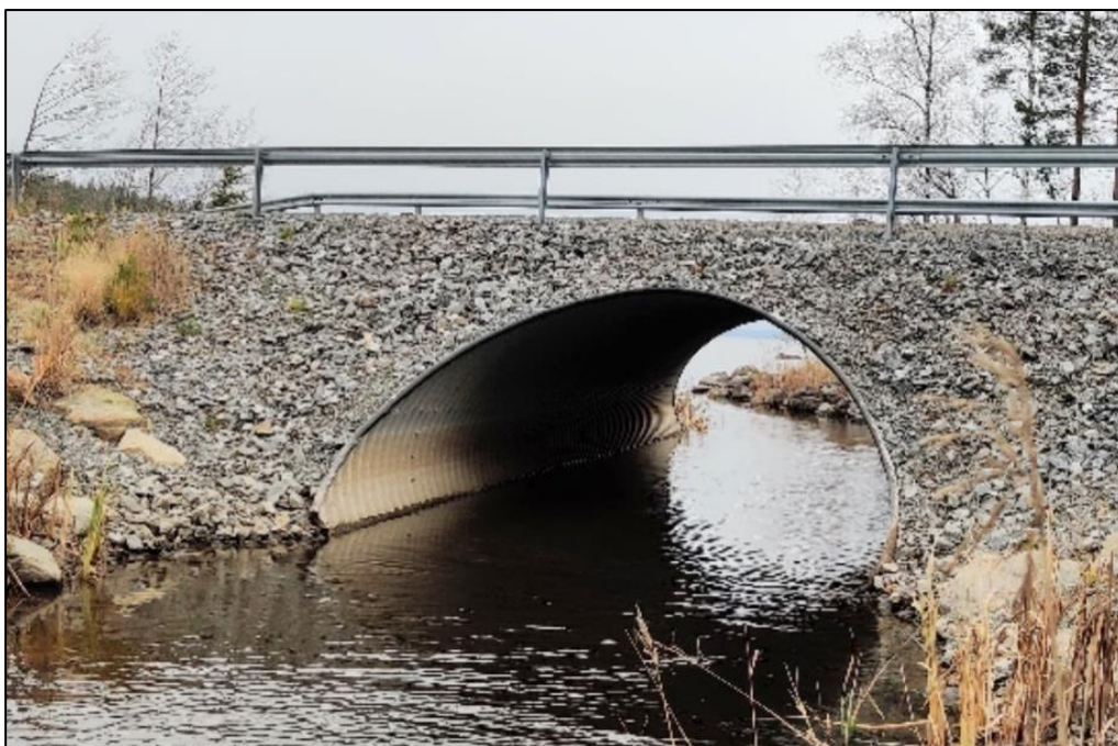
Figur 3-54: Ved kryssing av mindre bekker og elver kan løsninger, som vist her, også benyttes. Løsningene skal ivareta flom, med bunnsstrat for fisk og erosjonssikring (Kilde: Sweco).
