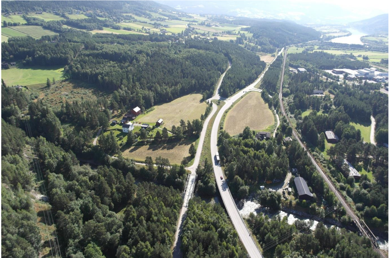
Figur 2 Dagens situasjon ved Forråbru, Dovrebanen til høyre
