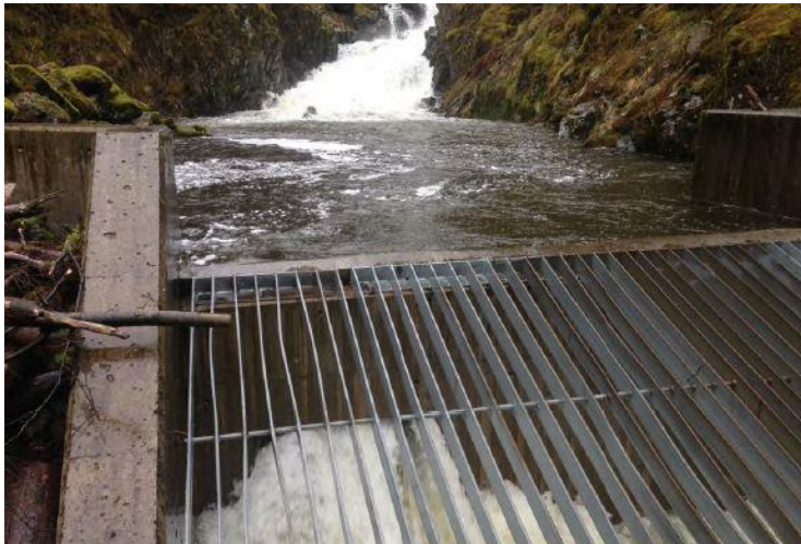
Figur 24 Eksempel på selvrensende rist og sedimentasjonskammer (NVE), Forkaldrud, profil 7650
