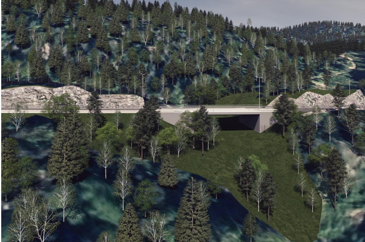
Figur 8-13: Hegland faunapassasje under bru. Her er det sikret tilstrekkelig bredde, og det er satt av plass til beitevegetasjon. (Kilde: Sweco).
