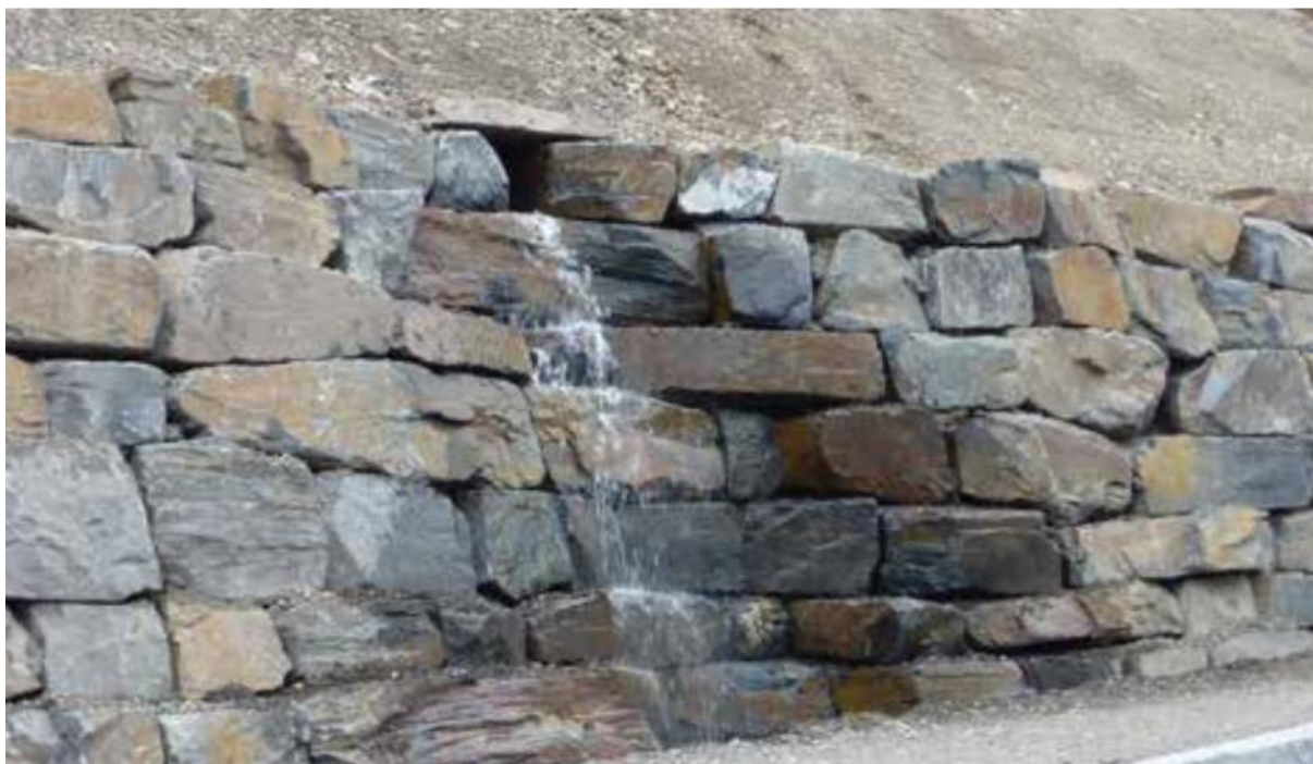
Figur 8-2: Eksempel på støttemur. (Kilde: Estetisk veileder, [1]).
