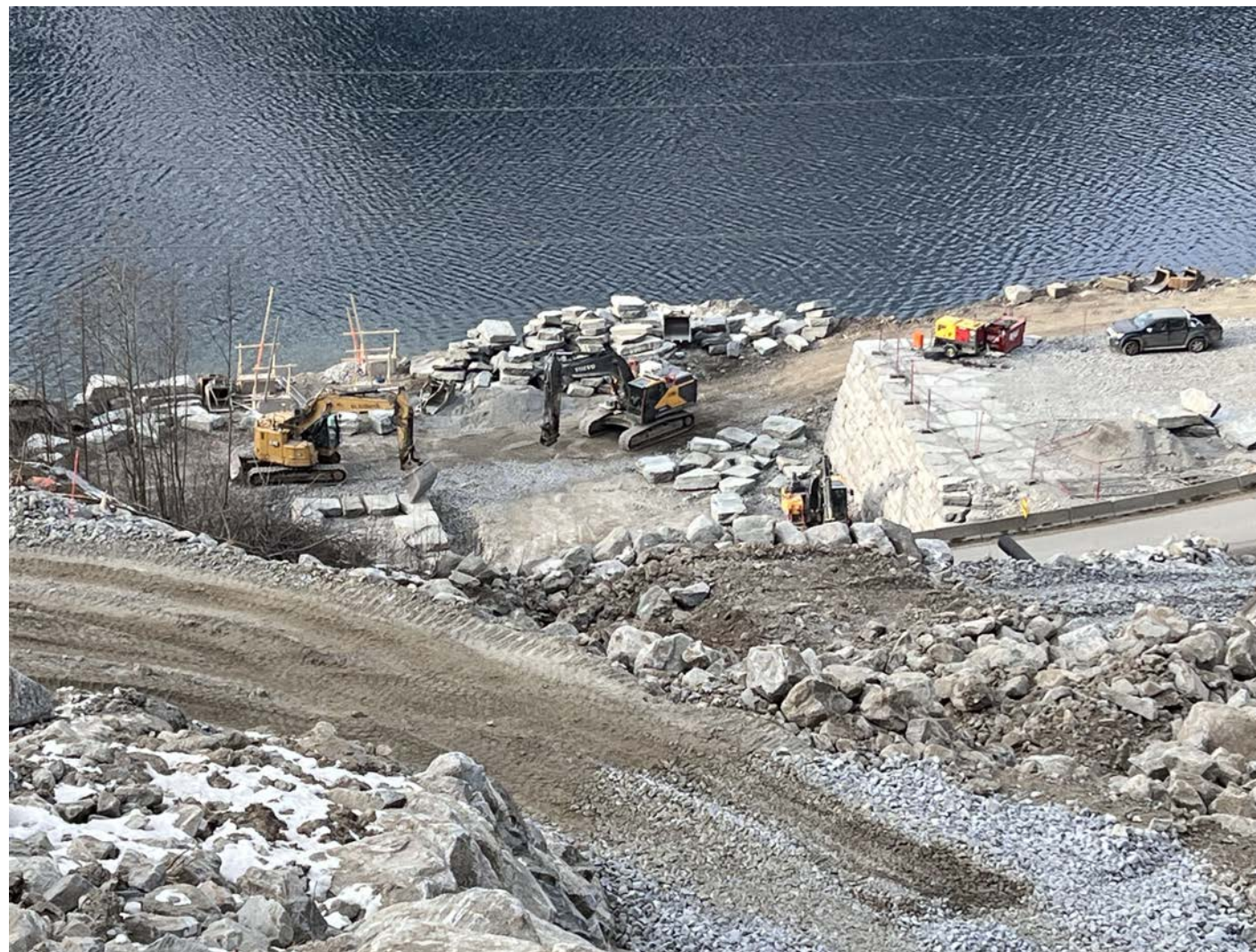
Foto: Anleggsaktivitet på Rv13 der vi bruker lokal stein til støttemurer, Nye Veier / Jens Erik Farsjø
