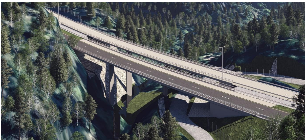
Figur 4-7 Tyvannselva bru I. Sett mot øst. Dagens bru i bakgrunnen med lysere asfalt. (Kilde: Sweco).
