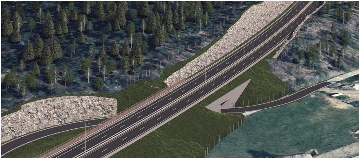
Figur 4-16 Omlegging av Gamle Sørlandske under E18. (Kilde: Sweco)
