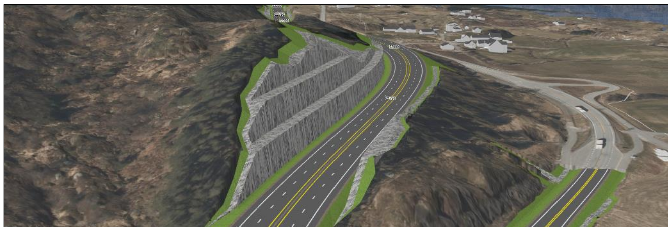
Figur 4-7: Bergskjæring med 10 meter pall-høyde og 5 meter fjellhyll
