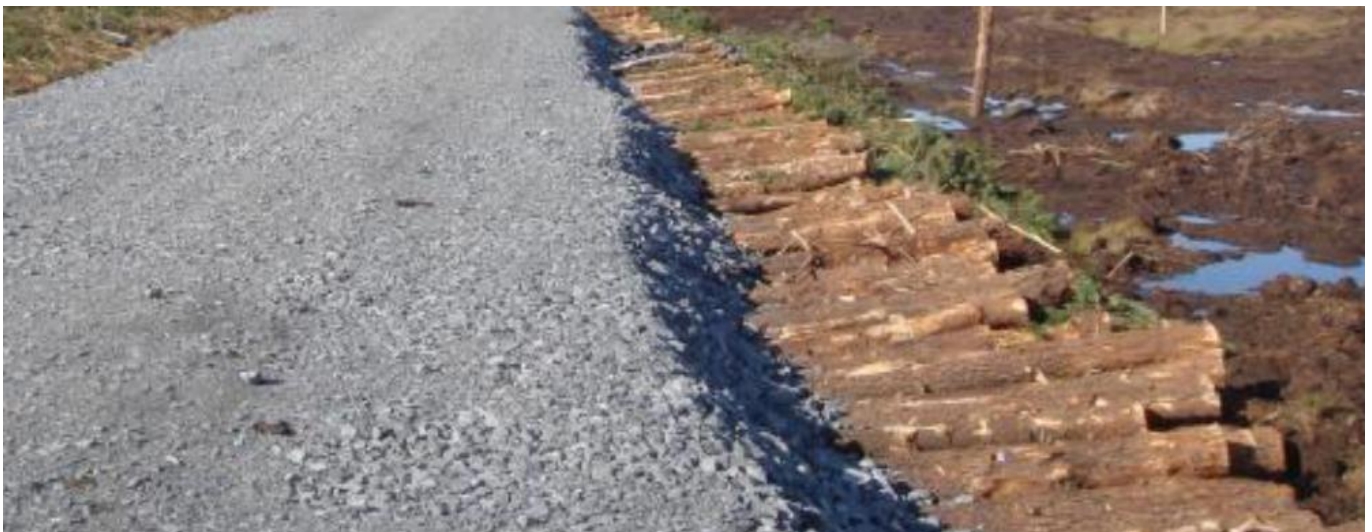
Figur 9-2: Bruk av tømmerstokker for å etablere flytende anleggsvei. Foto: Roadex Network, 2022
