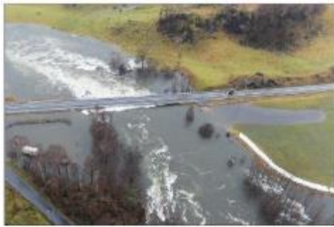
BJERKREIM BRU OVER E39
