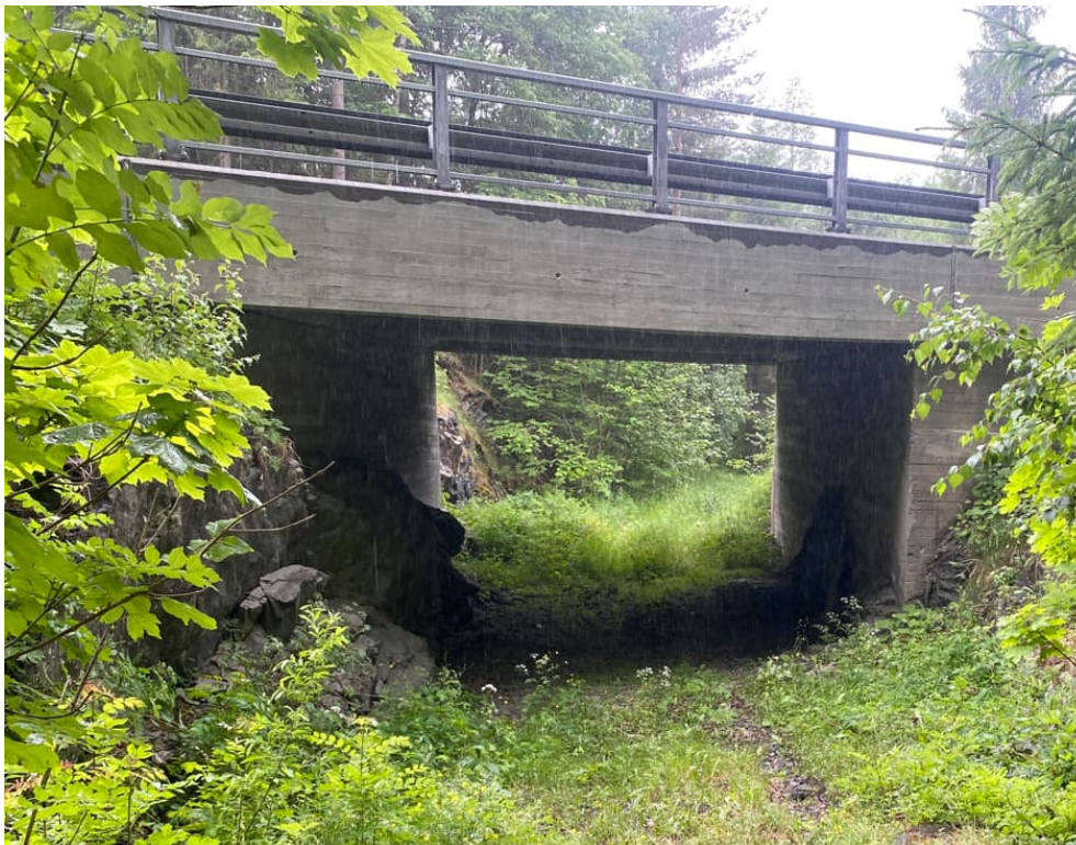
Figur 3-15: Kulvert ved Ødegård. (Kilde: Sweco).
