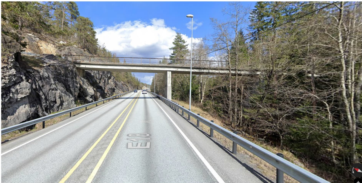
Figur 3-42: 08-0757 Handfang bru (Rørholtveien). (Foto: Google Street view).
