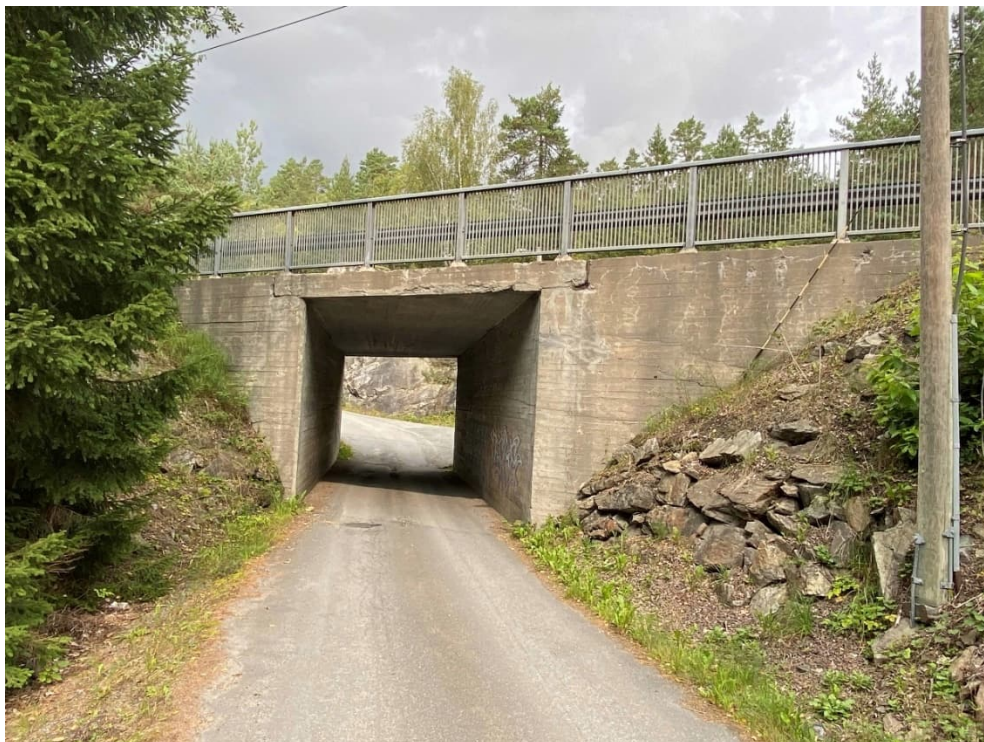
Figur 3-51: 08-0718 Dørdal 5, kulvert under E18. (Kilde: Sweco).
