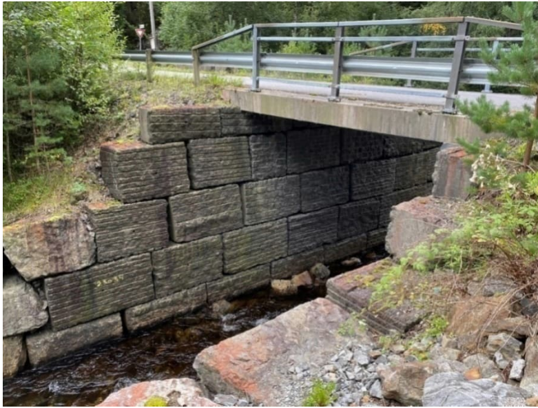
Figur 3-39: Gongelva bru (Eks. bru Bakkeveien). (Kilde: Sweco).
