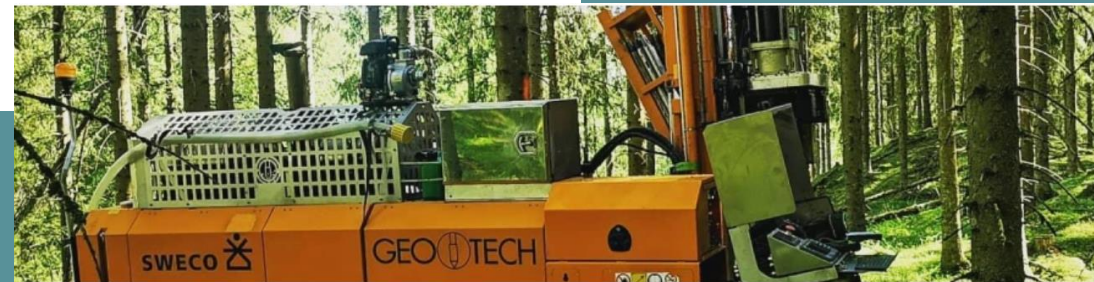
Vi gjennomfører grunnundersøkelser for ny E39 Bilstad - Bue
