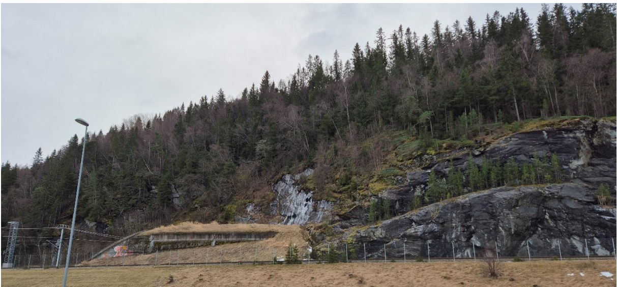
Figur 32: Oversiktsbilde av bergskjæring og bratt terreng mot sør mellom eksisterende påhugg for Helltunnel og Gjevingåstunnelen (jernbanetunnelen). Skredportal for Gjevingåstunnelen kan sees lengst til venstre i bilde.
