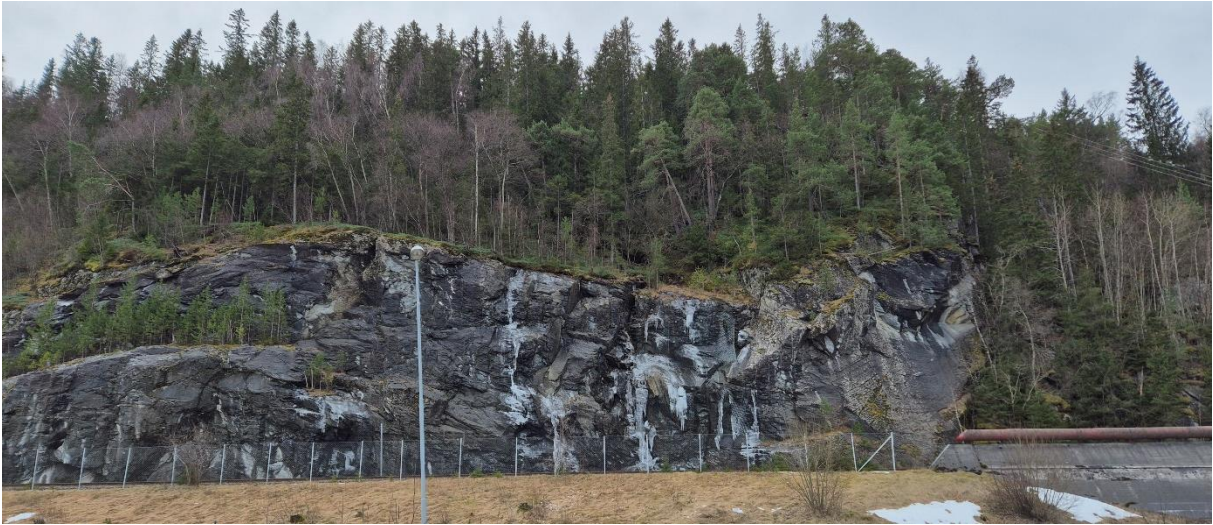
Figur 31: Oversiktsbilde av bergskjæring og bratt terreng mot sør mellom eksisterende påhugg for Helltunnel og Gjevingåstunnelen (jernbanetunnelen).
