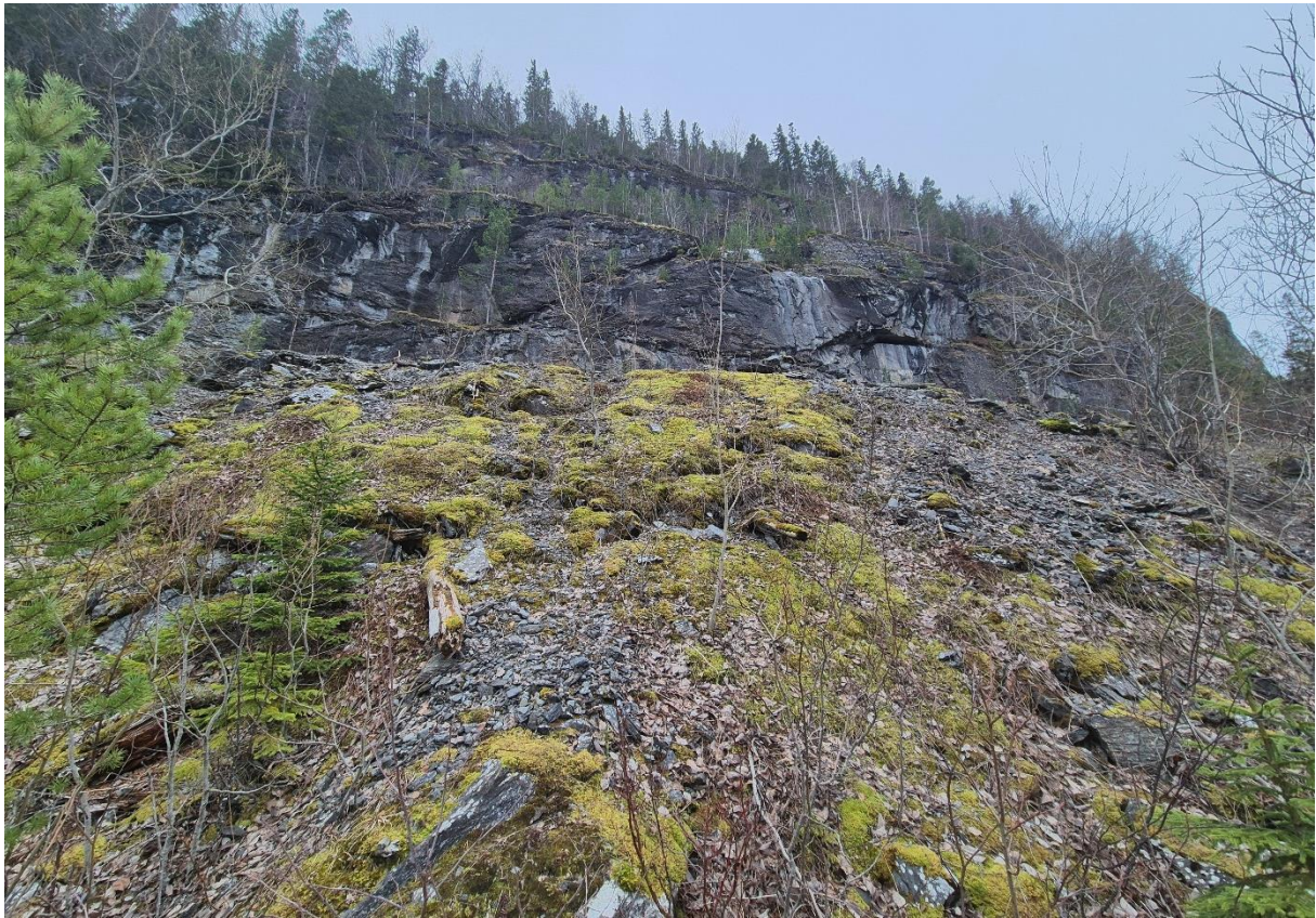
Figur 27: Oversiktsbilde av bergskjæring og klipper i overkant fra tursti nord for jernbanen.
