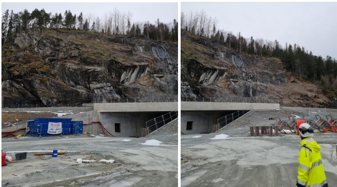
Figur 21: Oversiktsbilde av portalområdet for ny Helltunnel fra 28. januar 2025.
