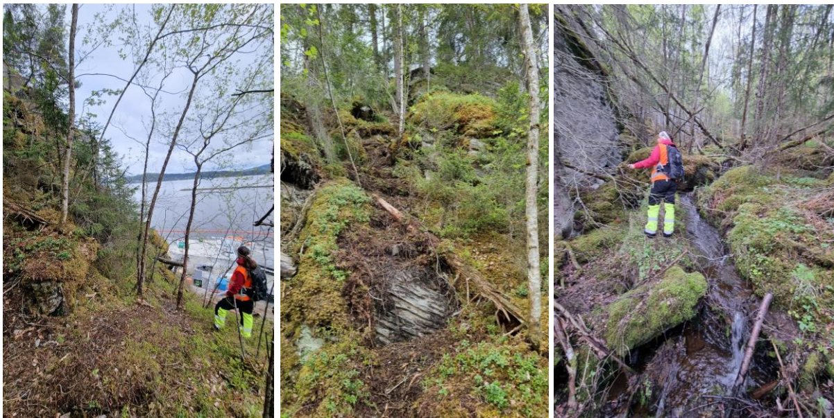
Figur 28: Bratt terreng ned mot påhugg for eksisterende Helltunnel mot ny Helltunnel (venstre, midt). Det renner en bekk på grov ur i forsenkningen sør for eksisterende Helltunnel (høyre).
