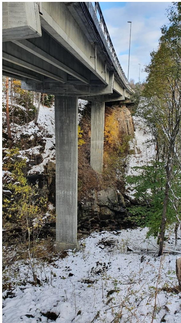
Figur 4-7 Østsiden av dagens bru sett mot nordøst. NIB-bjelkebru bygd i 1971 (kilde: Sweco).
