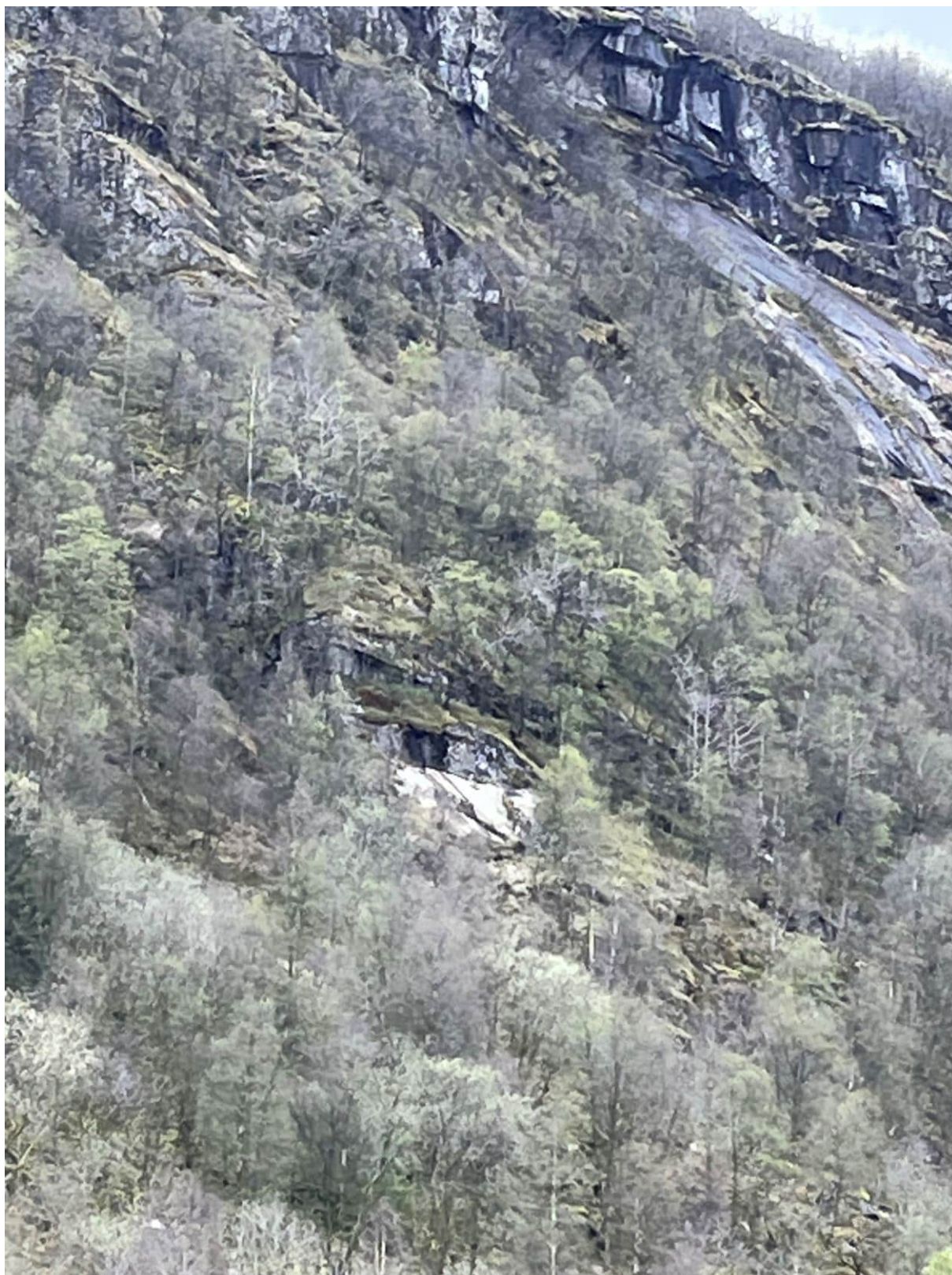
Vedlegg: Rasfarlig fjell 2
