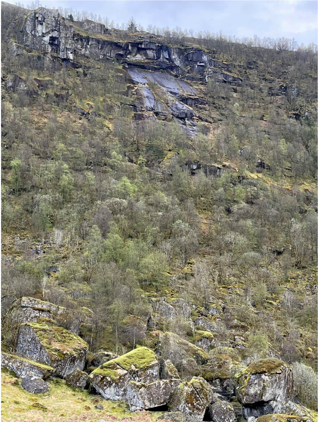
Vedlegg: Rasfarlig fjell
