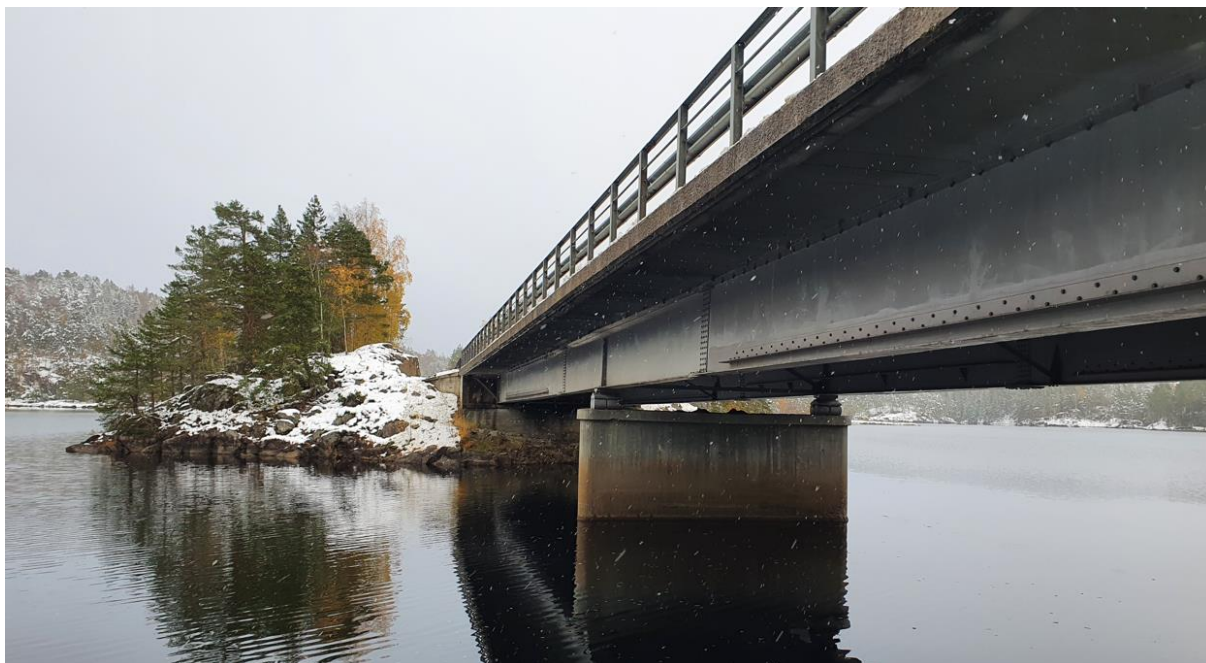
Figur 6-34 Eksisterende Bakkevannet bru. Sett mot øst.
