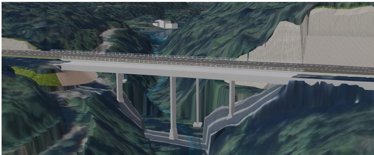
Figur 6-7 Tyvannselva bru. Sett oppstrøms. Dagens bru i forgrunnen. Ny bru for sørgående løp i bakgrunnen.
