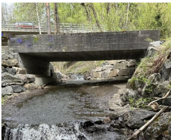
Figur 6-23 Eksisterende bru på landbruksveg nedstrøms med dagens E18 bru i bakgrunnen. Sett oppstrøms.
