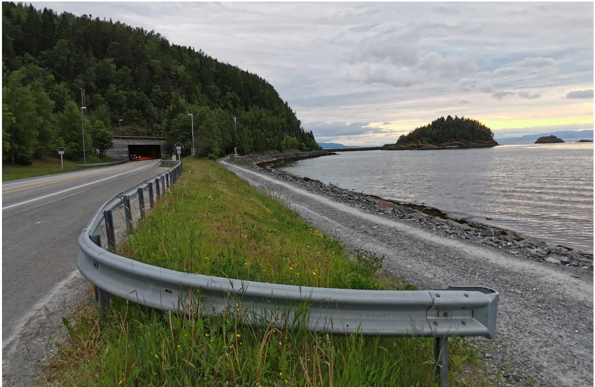
Figur 37: Turvegen blir bredere ved tunnelåpningen. Bilde viser at autovernet er åpent for innkjøring (foto: Rambøll/Henning Larsen).
