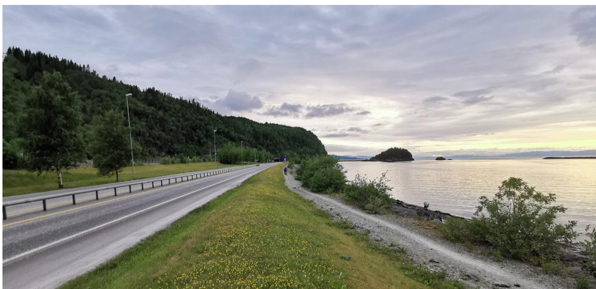
Figur 8: E6 langs Hellstranda og Trondheimsfjorden (Foto: Rambøll, 2020).
